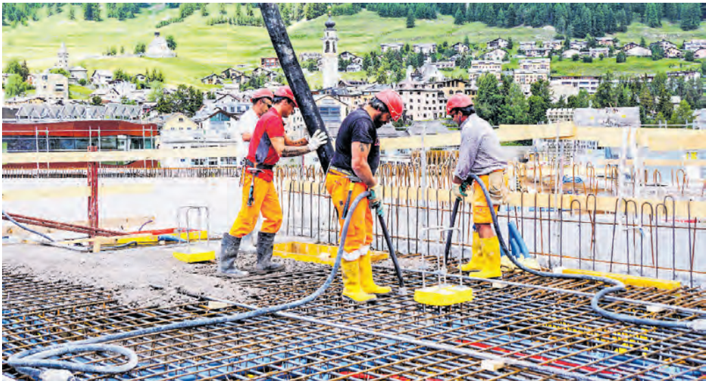
Mit Wasser und Spezialzement wird im Betonwerk Recyclingbeton hergestellt, der per Lkw auf die Baustelle gefahren und dort eingebracht wird. Bild links: Flurin Wieser im Kontrollraum der Betonproduktion.
