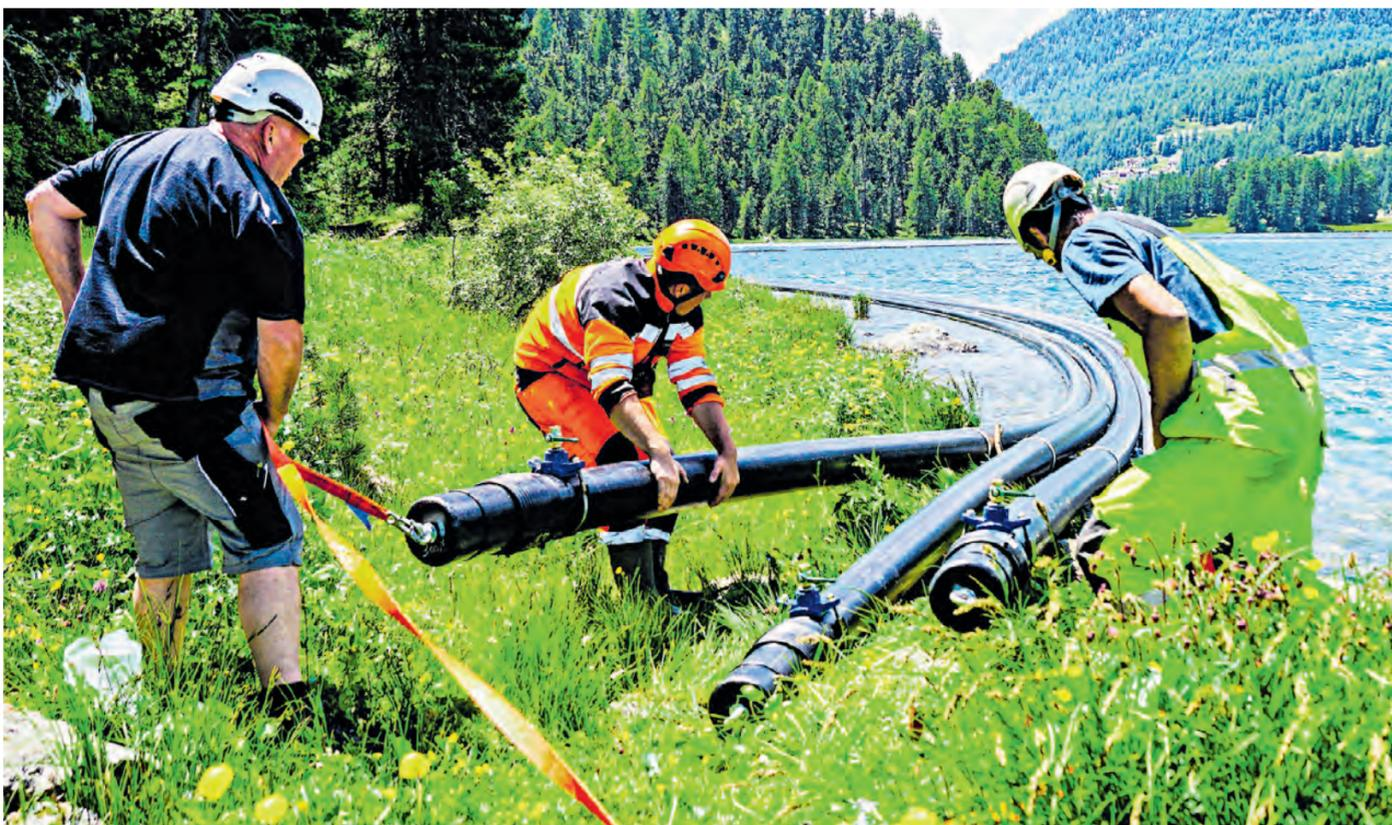
Mitarbeiter von Repower und des Kabellieferanten Brugg Cables hieven die Kabelrohre kurzzeitig aus dem Wasser, um Ventile zum Ausgleich des Wasserdrucks fertig zu montieren. Dieser Teil der Rohre kommt später in einem Kabelschacht am Seeufer zu liegen. Foto: Jon Duschletta
