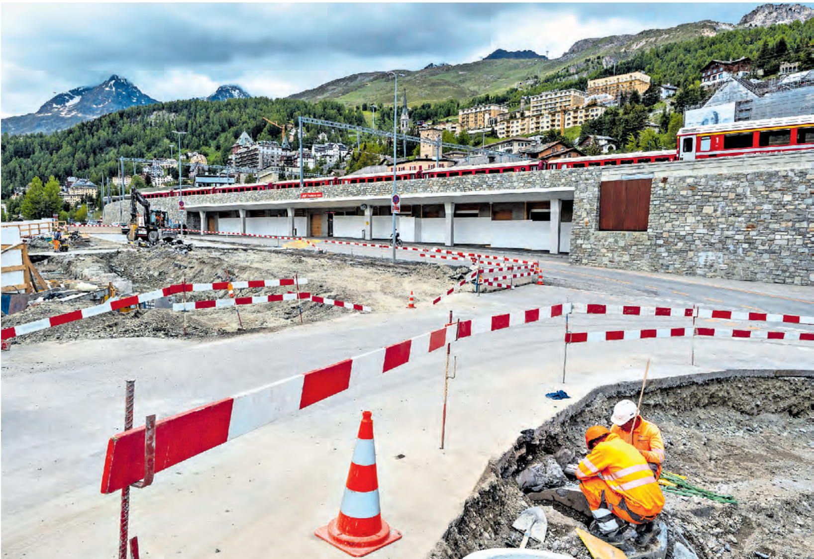
Eine komplexe Baustelle: Hier entsteht der Kreisel Dimlej in St. Moritz.
