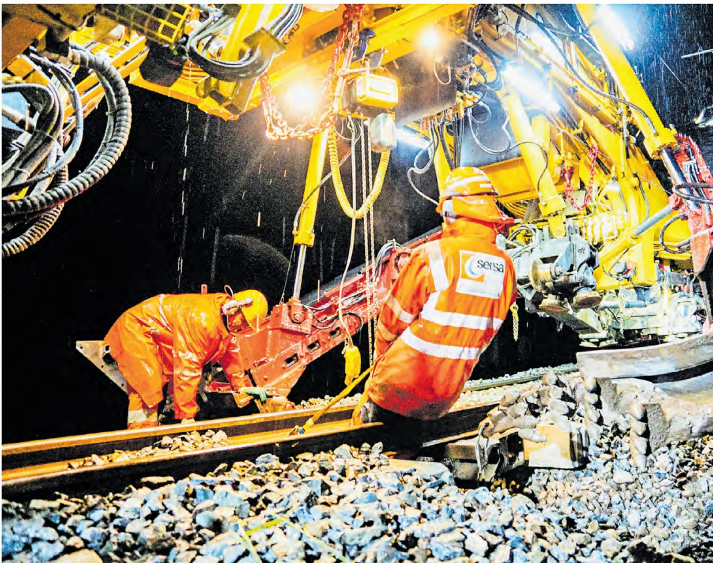
Arbeiter der RhB und der Gleisbaufirma Sersa erneuern zurzeit den Oberbau der Geleise bei Cinuoschel/Brail. Einblick in die Arbeiten auf Seite 3. Foto: Jon Duschletta
