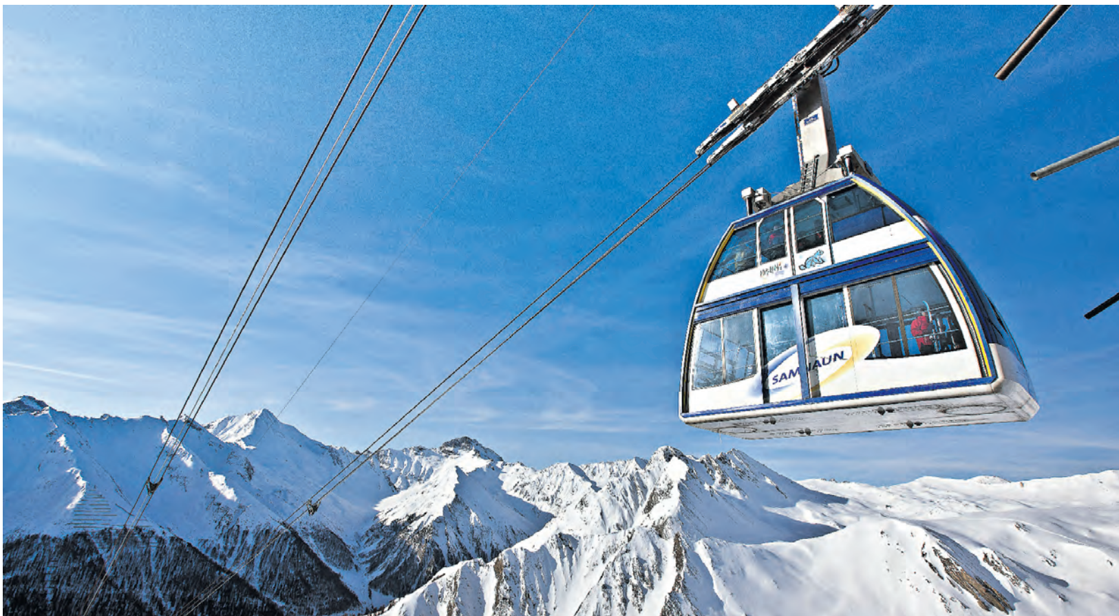
Die Bergbahnen Samnaun AG benötigt viel Geduld, um die Skigebietserweiterung realisieren zu können.
