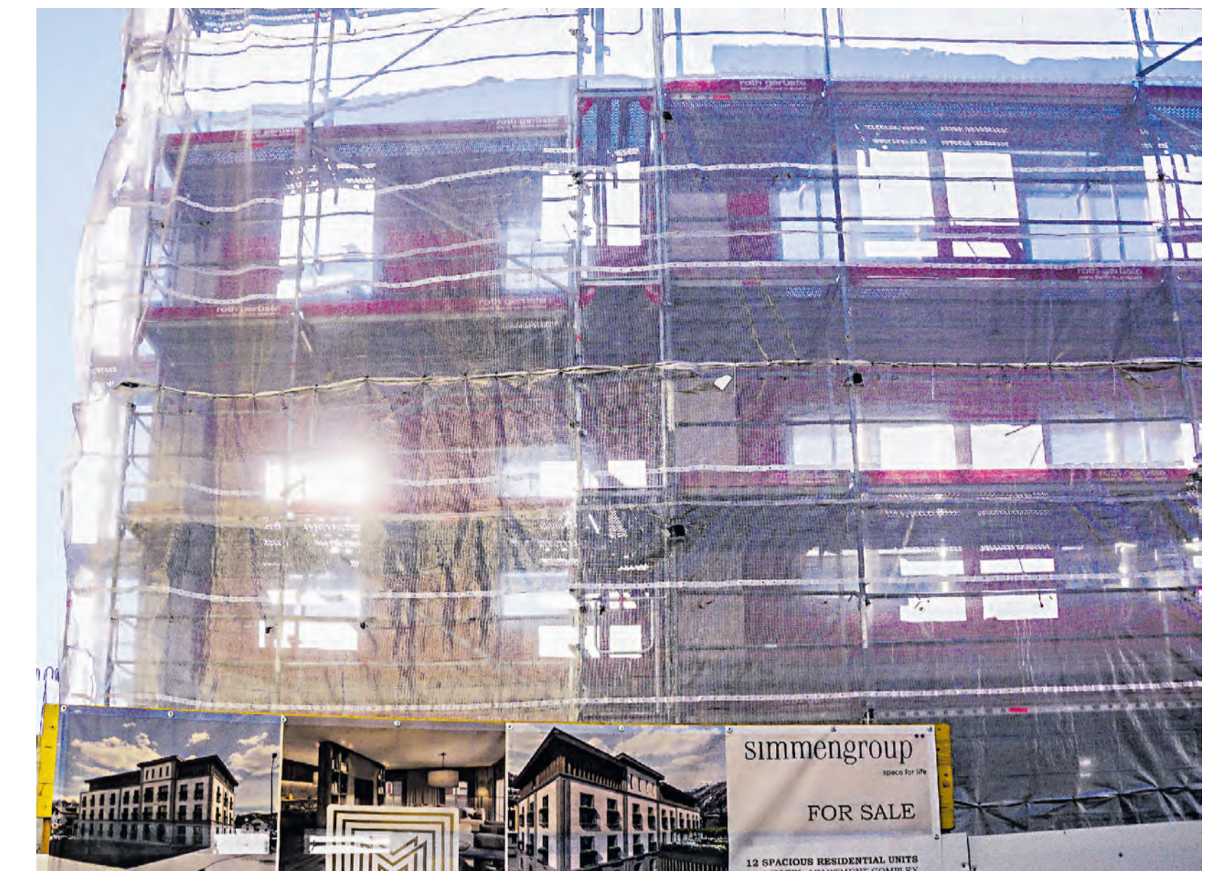
Die Hotelfassade des Misani in Celerina dürfte das Dorfbild auch in den nächsten Wochen und Monaten prägen. Noch werben die Plakate der Simmen Group für den Verkauf der Eigentumswohnungen. Allerdings soll das Projekt in der Zwischenzeit verkauft worden sein. Foto: Jon Duschletta
