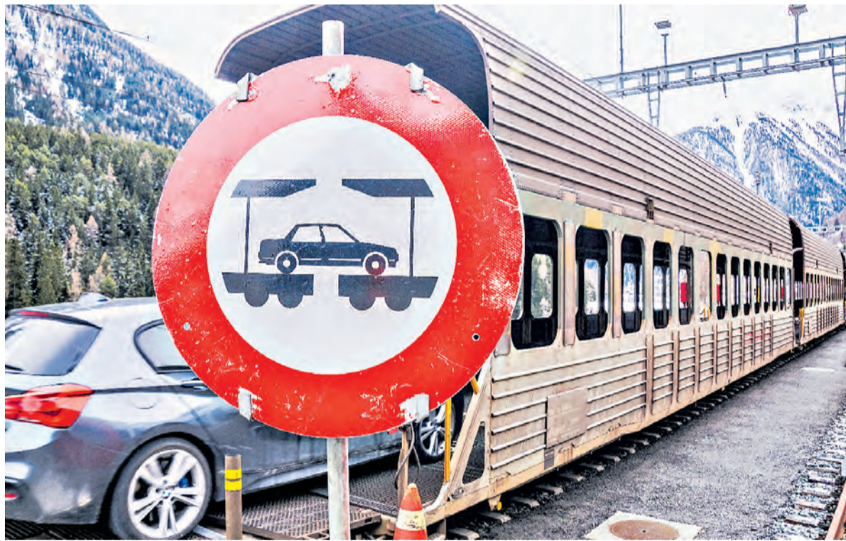
20 Jahre Betrieb mit dem sich abzeichnenden Rekord von knapp einer halben Million transportierter Fahrzeuge im laufenden Jahr haben an der Infrastruktur des Vereina-Autoverlads ihre Spuren hinterlassen. Foto: Jon Duschletta
