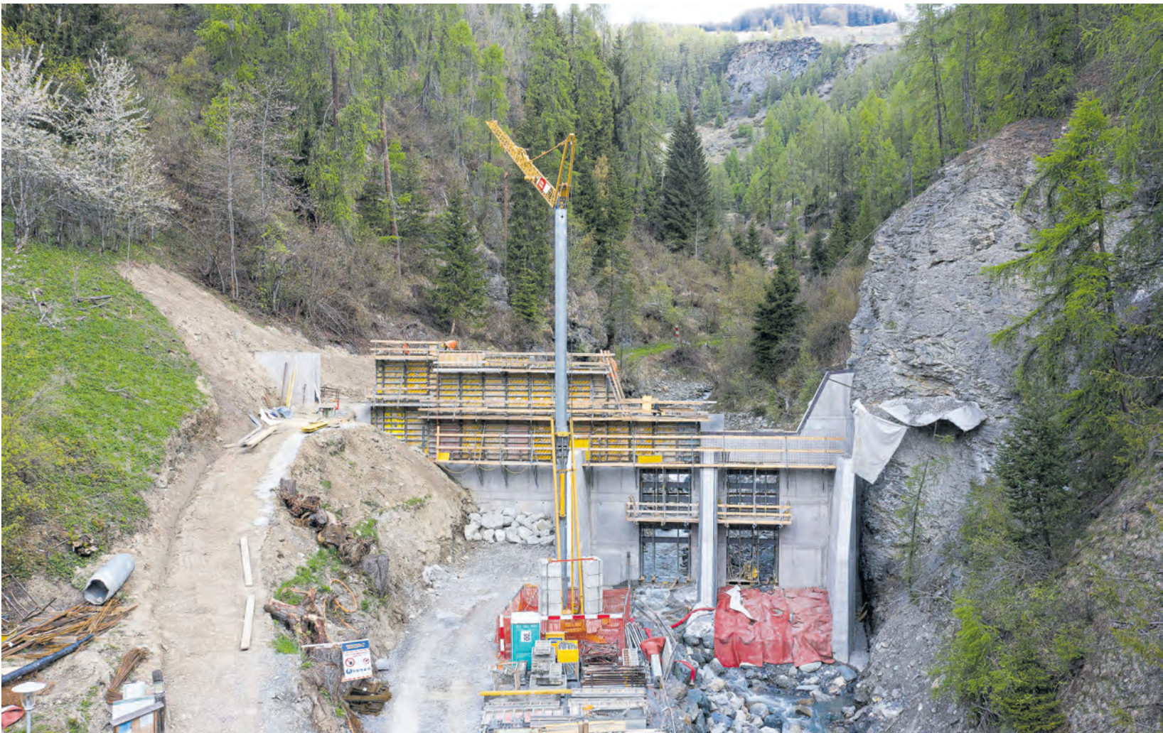
Il cumün da Scuol fabrica ün grond batschigl da material illa Val Clozza per evitar dons da boudas in cumün.
