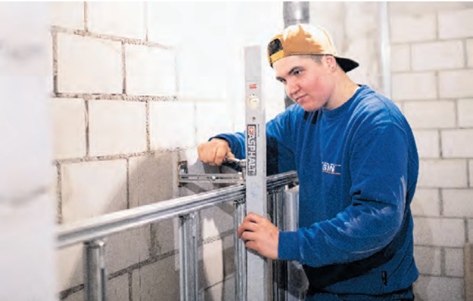
Silvano Gini montiert eine Vorrichtung für ein Waschbecken.
