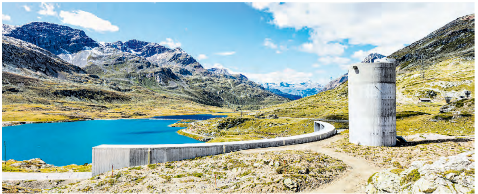
Der Siloturm des neuen Unterhaltsstützpunktes fällt besonders auf.
