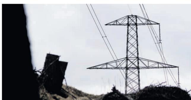
Solche, bisher einseitig belegten Höchstspannungsmasten, werden durch die Swissgrid mit einer zweiten Leitungsebene bestückt. Foto: Jon Duschletta
