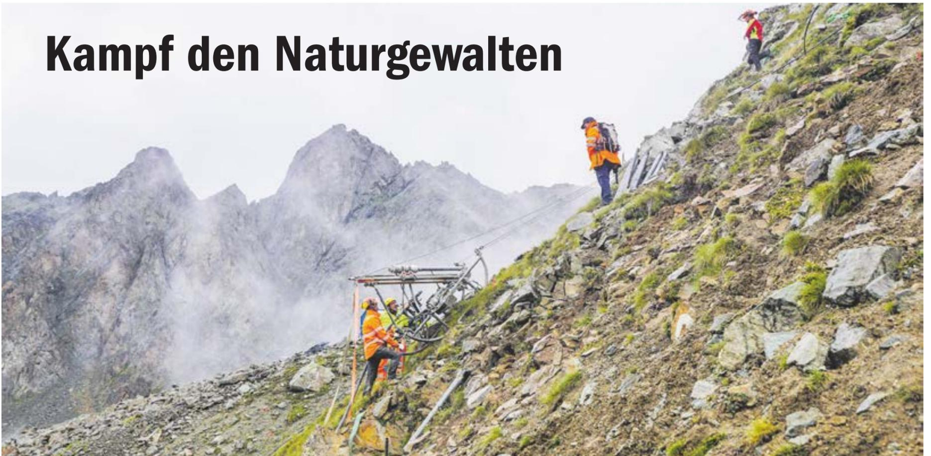
In Pontresina sind aktuell Spezialisten der Misoxer Baufirma Geotecnica mit Montagearbeiten für Steinschlagnetze beschäftigt. Dies auf 2800 Metern über Meer – und jeder Wetterlage ausgesetzt. Foto: Jon Duschletta
