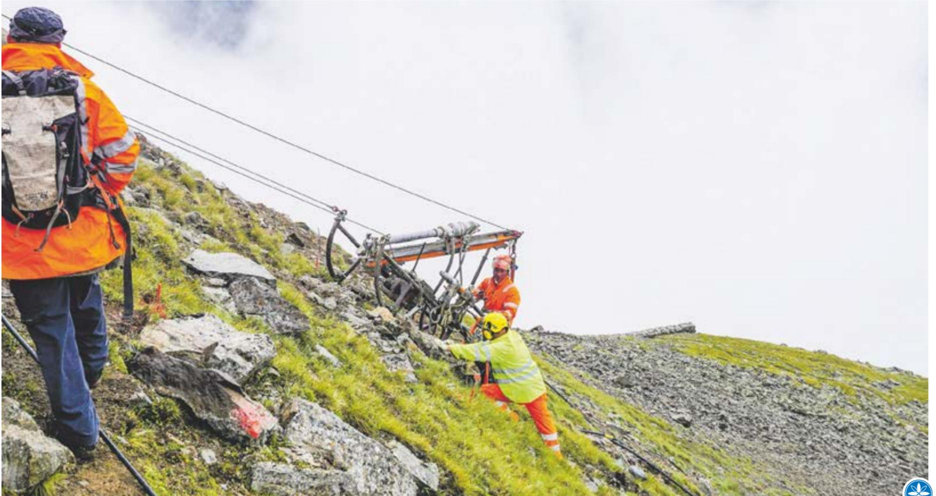
Ankerbohrungen am steilen Muot da Barba Peider erfordern einiges an Improvisationstalent der Bauarbeiter. Weitere Bilder der Baustelle gibt's mit der «EngadinOnline»-App.
