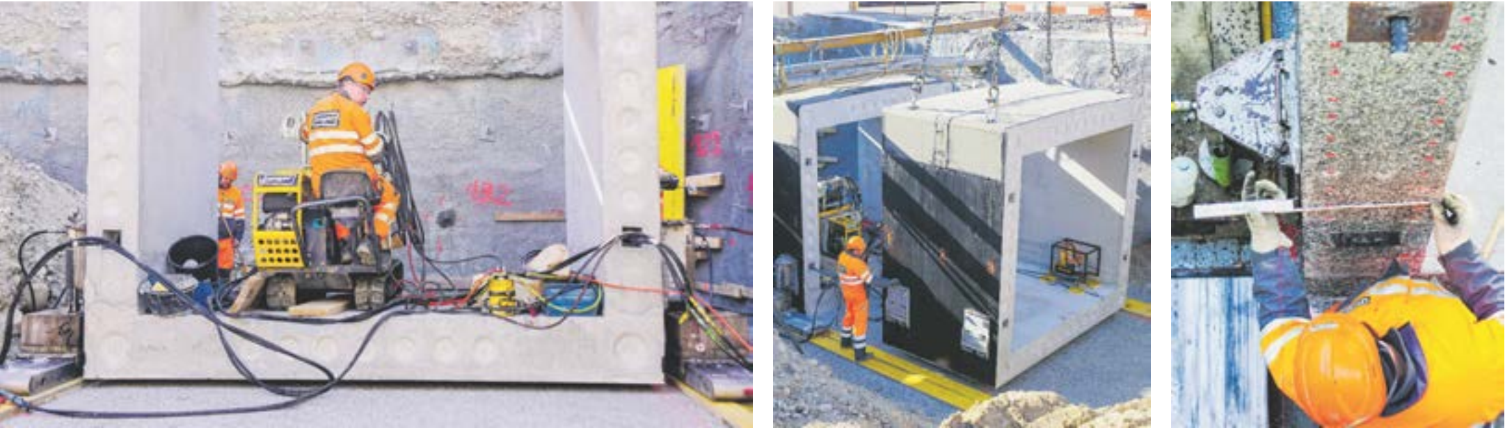
Am Dienstag wurden beim Bahnhof Bever vier vorgefertigte Betonelemente einer Obwaldner Spezialfirma angeliefert und vor Ort zum rund acht Meter langen Herzstück der zukünftigen Unterführung zusammengefügt. Die Versatzarbeiten dauerten nur wenige Stunden, erforderten aber millimetergenaues Arbeiten. Hinter dem Hauptfoto verbirgt sich eine «EngadinOnline»-Bildergalerie. Fotos: Jon Duschletta
