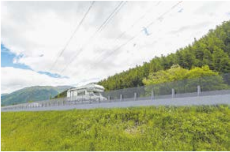
Die Lärmschutzwände entlang der Kantonsstrasse werden als Betonsockel mit einer Glaswand gebaut.
