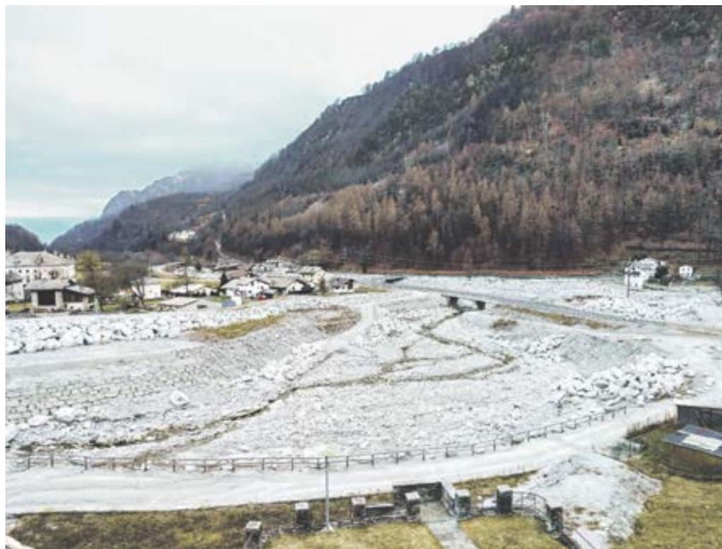
Bild vom Auffangbecken im Talgrund bei Bondo. Die im Bild erkennbaren Schutzdämme sind Provisorien. Ersetzt und neu angelegt wird auch die Bondasca-Brücke mitsamt einem Teil der Kantonsstrasse. Foto: Anna Giacometti
