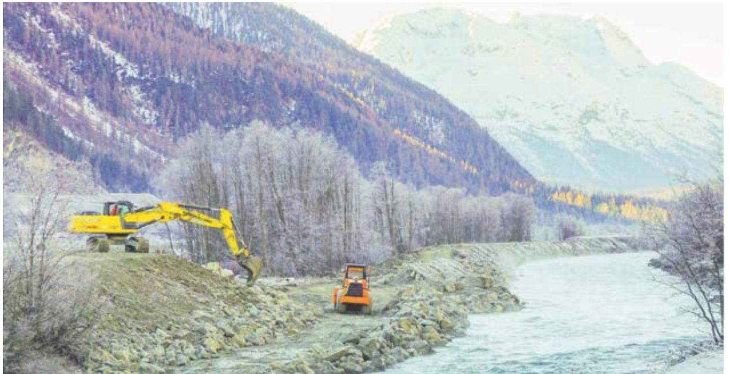
So lange es die Wetterbedingungen zulassen, wird am Rückbau des alten Inn-Damms (Bildmitte) weitergearbeitet. Vom Punkt aus, an dem der gelbe Bagger steht, wird der neue Damm in Richtung Bever links hinter dem Auenwäldchen durchgeführt.
