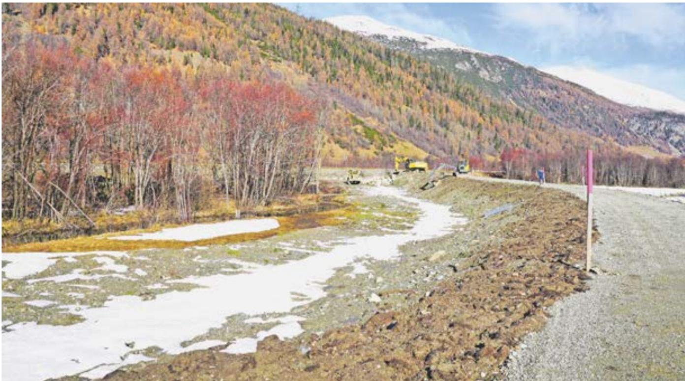
Blick flussabwärts auf den neuen Inn-Damm (rechts). Bei den Baumaschinen im Hintergrund in der Bildmitte endet die Revitalisierungsetappe «Bever II». Das bestehende Auenwäldchen (links) wird im neuen Gewässerraum des Inns zu stehen kommen und von diesem umflossen werden. Foto: Jon Duschletta
