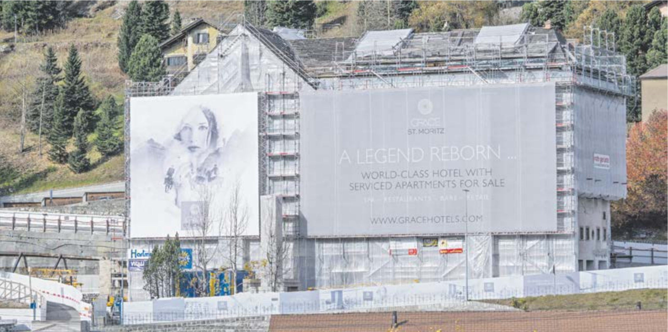
Zurzeit ruhen die Bauarbeiten beim Hotel La Margna in St. Moritz. Die Eigentümer hoffen, im nächsten Frühjahr die Bauarbeiten weiterführen zu können. Foto: Reto Stifel
