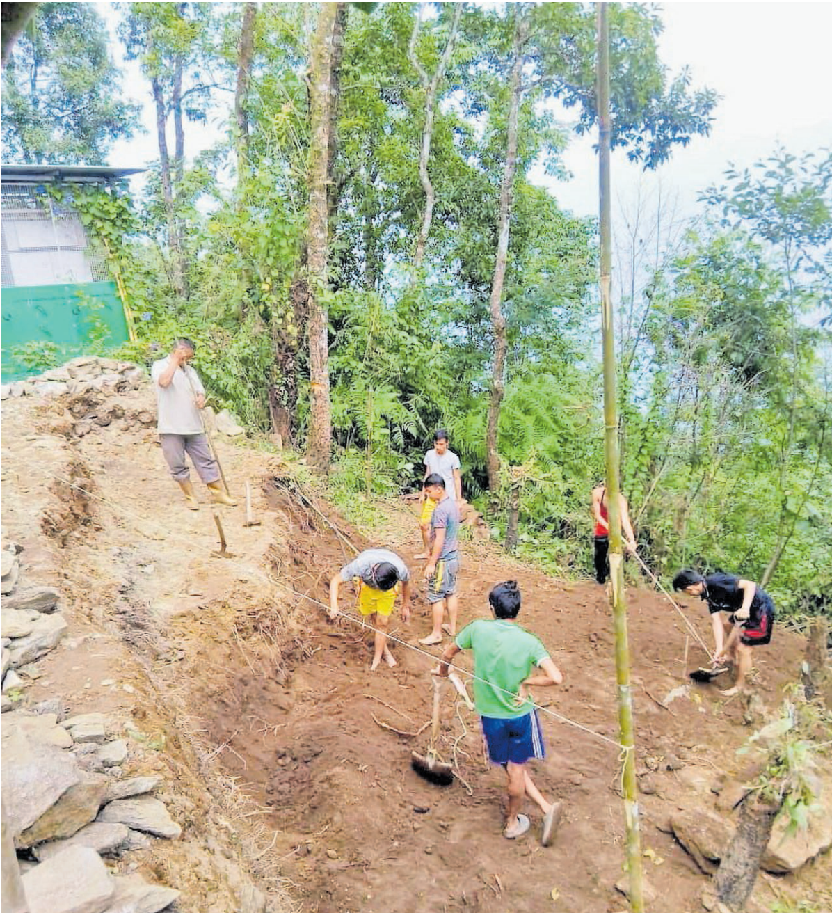
Mit einfachen Mitteln wurde die Baustelle vermessen und das Haus positioniert.
