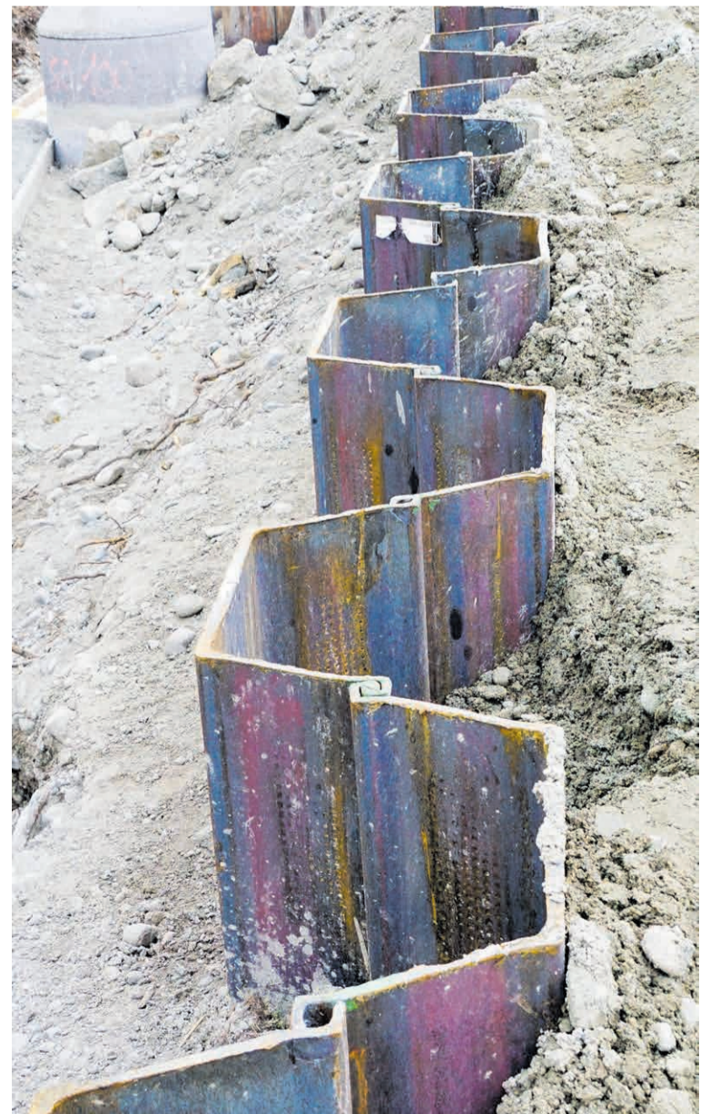
Die 515 Meter lange Spundwand wird nach Fertigstellung der beiden unterirdischen Stockwerke der Überbauung wieder entfernt.
