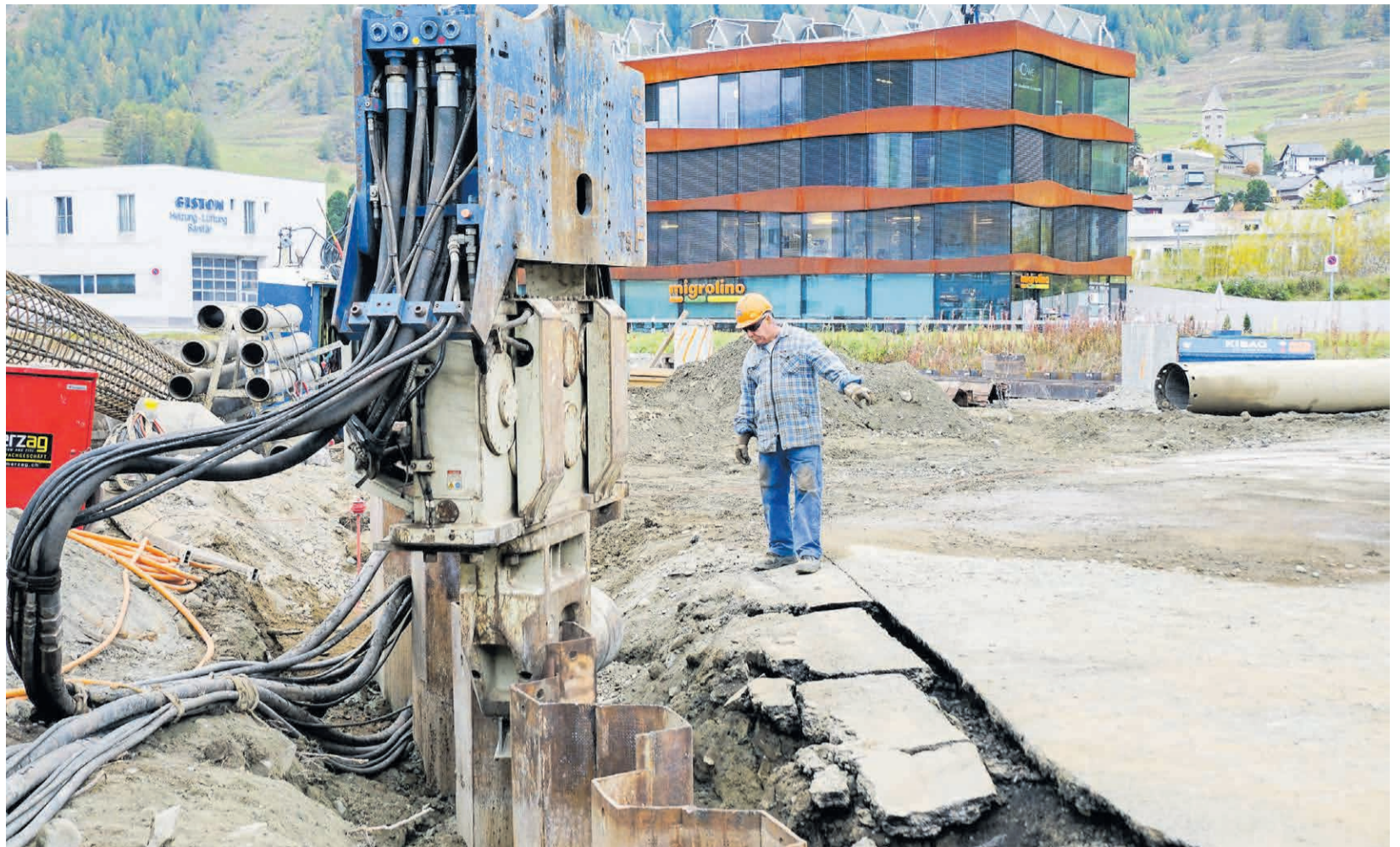
Fredy Fessler von der Spezialfirma für Wasser- und Tiefbau Kibag mit Ableger in Pontresina gibt Anweisungen an den Maschinenführer. Dieser vibriert mit einer sogenannten Vibroramme an einem 90-Tonnen-Seilbagger die 20 Meter langen Spundwandelemente in den kiesigen Untergrund. Fotos: Jon Duschletta
