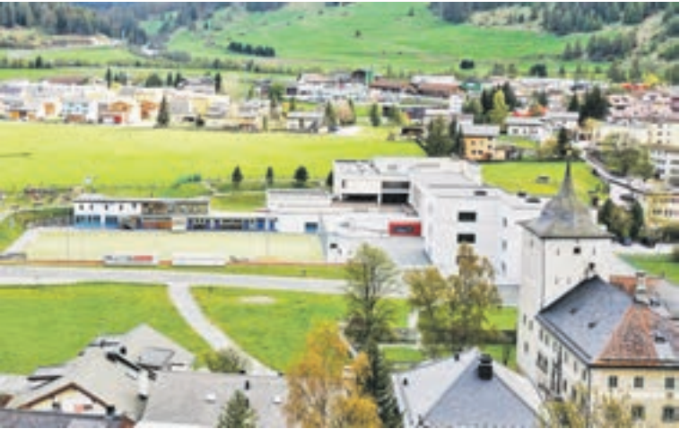
La chasa da scoula (a dretta) sto gnir sanada ed ingrondida. Per cha qual possa capitar sto il suveran dir schi a la revisiun locala. foto: Jon Duschletta
