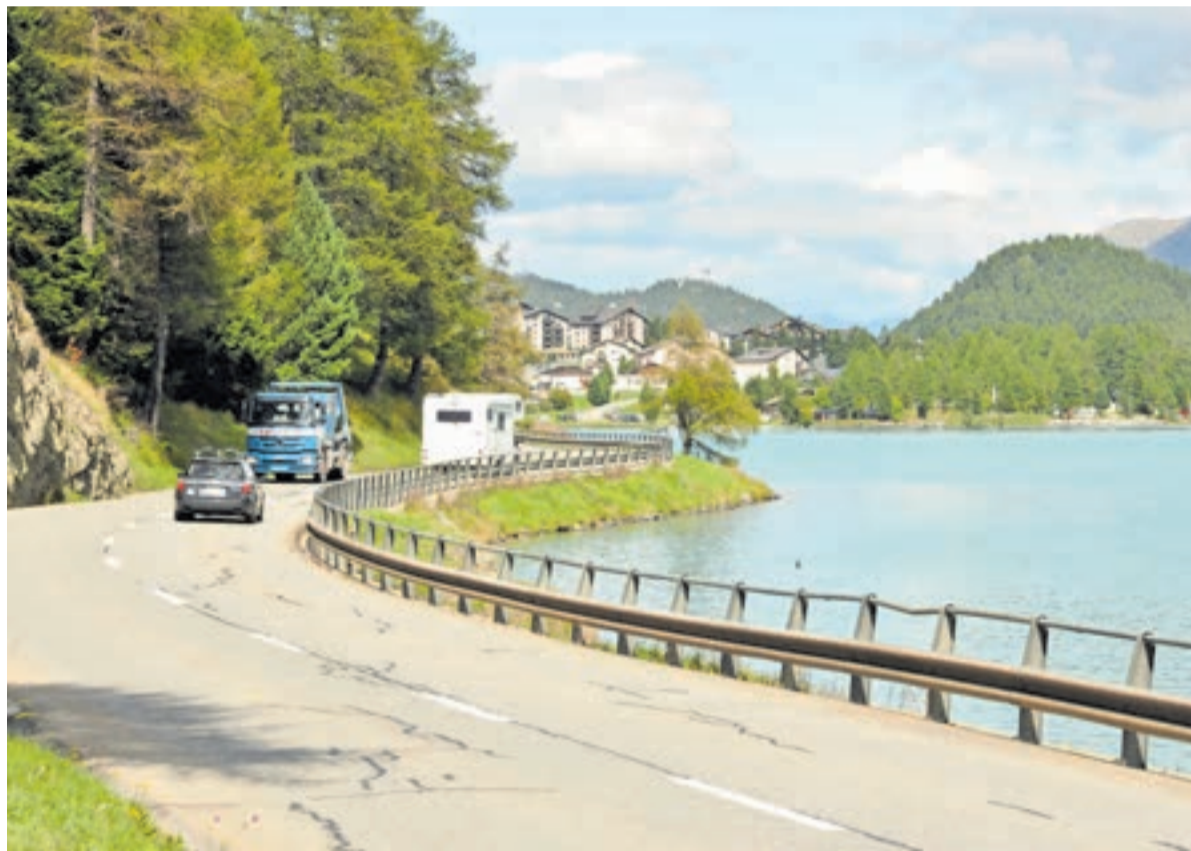
Dieser Strassenabschnitt zwischen Sils und Silvaplana soll verbreitert werden.
