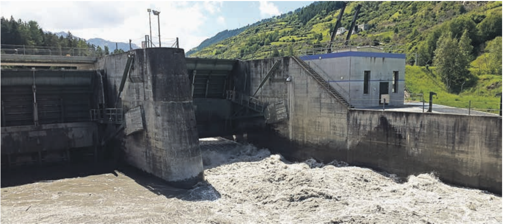
Eine Spülung bei der Stauanlage Pradella bei Scuol.
