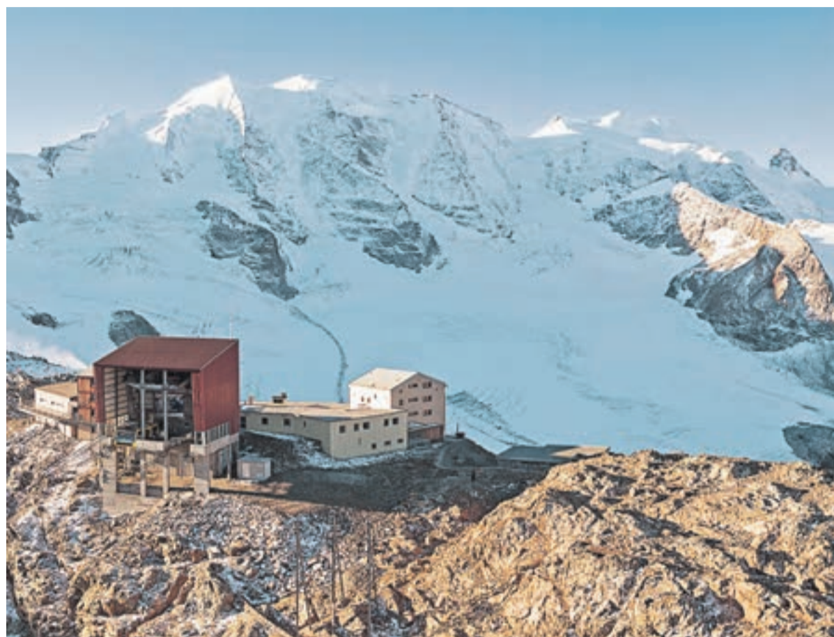
Auf der Diavolezza entsteht bald ein asphaltierter Rundweg.
