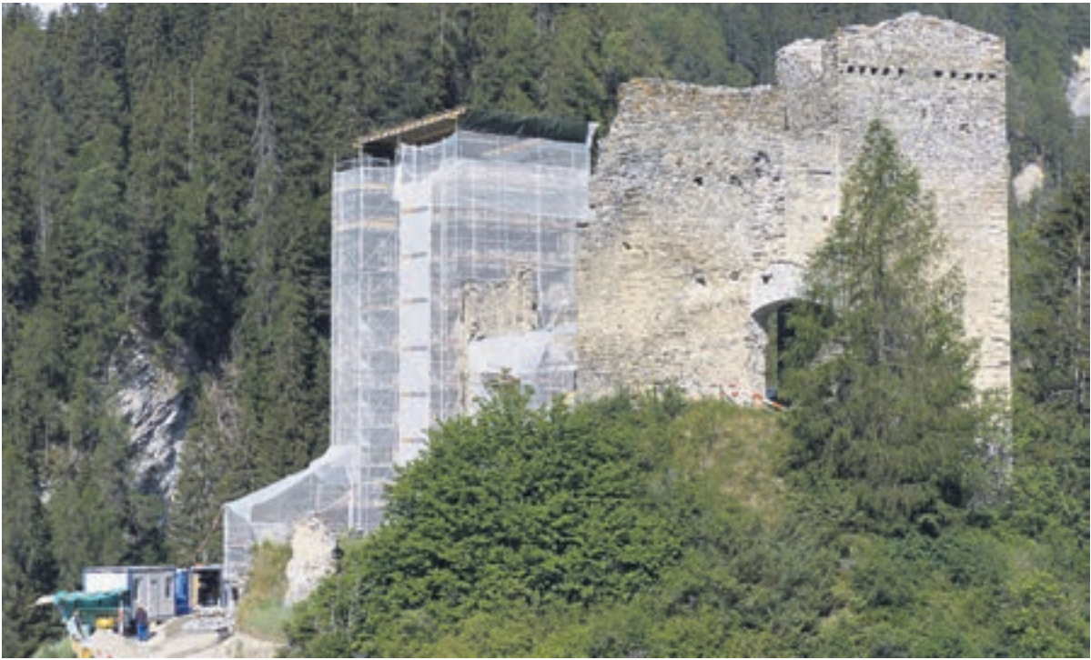
Il plazzal da fabrica ruina Tschanüff: 76 giarsuns müraders han prestà qua illas ultimas set eivnas var 3700 uras da lavur.
