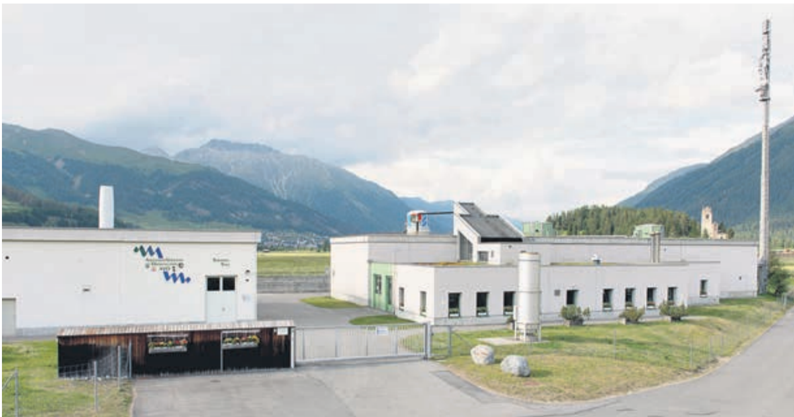
Ein Bild schon bald für die Vergangenheit: Ab 2021 kann die heutige ARA Staz in Celerina rückgebaut werden.
