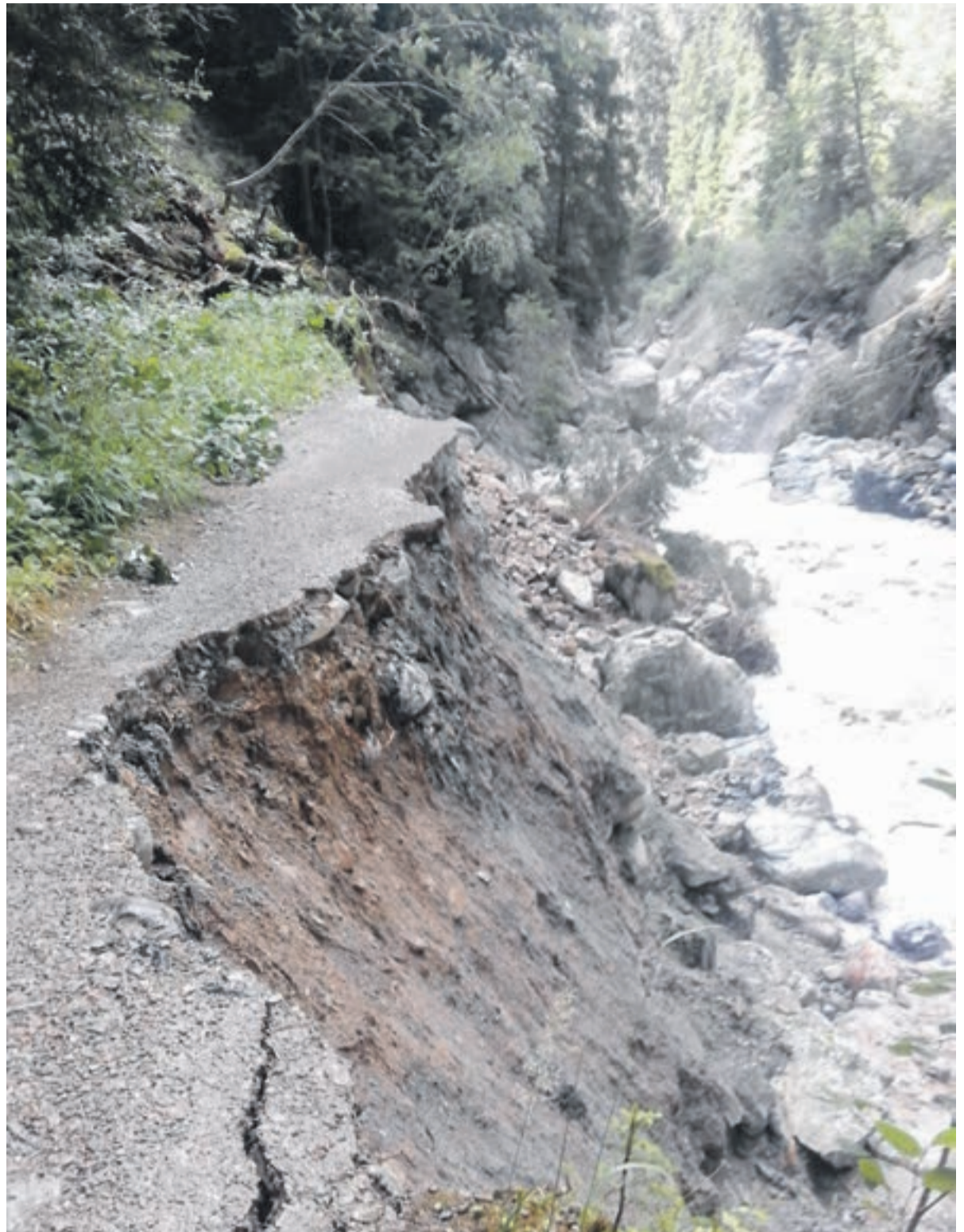
In divers lós illa chavorgia da la Clemgia a Scuol ha la bouda da l'on passà sdrappà cun sai tuot il material, tuot la terra, fin giò sül grip.
