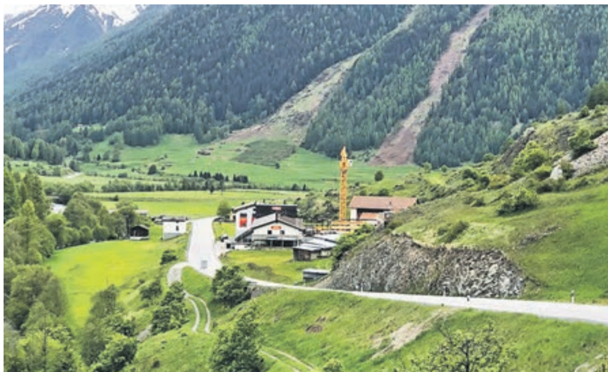
La nouva basa da l'Uffizi da construcziun bassa gnrà fabrichada dadaint Zernez.
