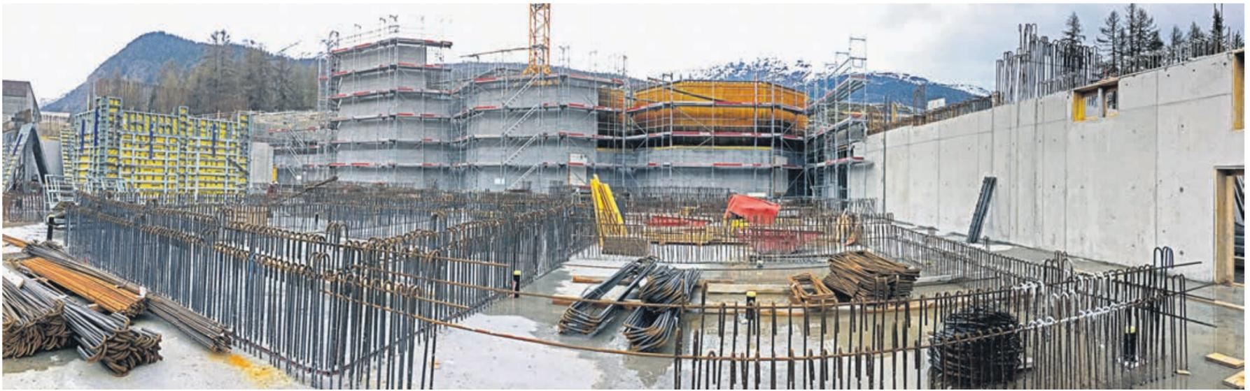
Blick auf die Industriegrossbaustelle der ARA Oberengadin bei S-chanf. Im Vordergrund entsteht die klassische, mechanische Vorreinigungsstufe, rechts davon das Blockheizkraftwerk. Im Hintergrund wachsen die drei grossen Faultürme in die Höhe. Der linke hat die Endhöhe praktisch erreicht. Links davon wird das neue ARA-Betriebsgebäude in Holzelementbauweise gebaut. Foto: Jon Duschletta
