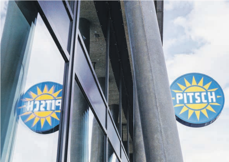
Vor einem Jahr erst wurde der Pitsch-Neubau in St. Moritz-Bad fertiggestellt und bezogen. Was jetzt dort passiert, ist noch offen.
