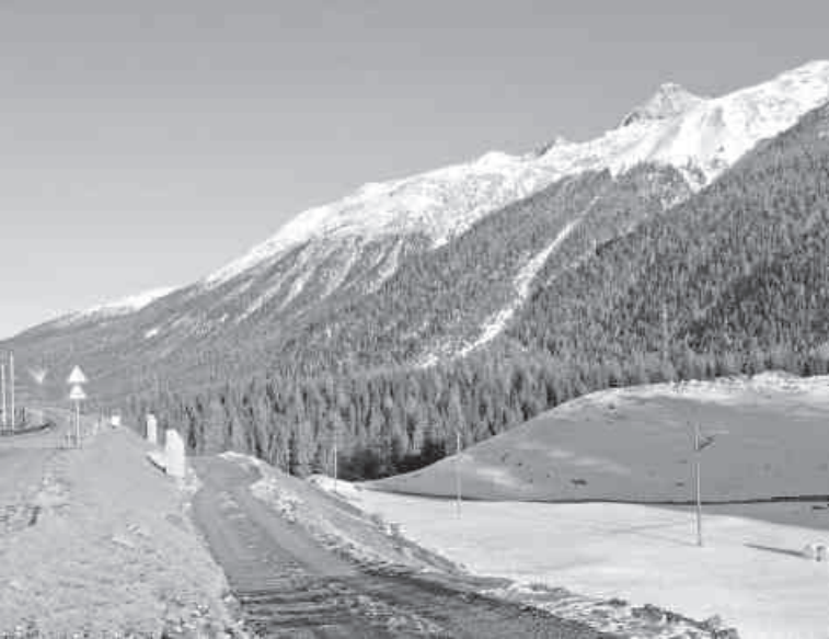
Im Bild die Deponie (rechts) und davor die aufzufüllende Geländemulde. Im Vordergrund die Baupiste zur Strassenerneuerung. Foto: Jon Duschletta
