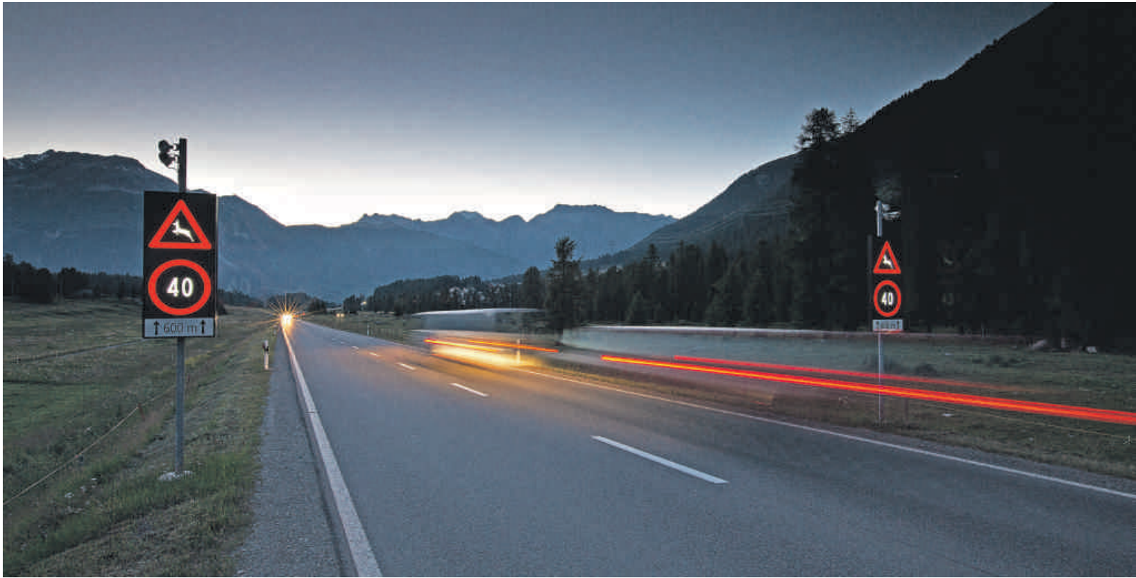
Effizient, aber teuer: Die Wildwarnanlage längs der Berninastrasse bei Pontresina.
