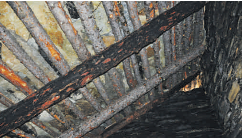
Alt und neu vereint: Neben den verrussten Balken sind neue eingesetzt worden.
