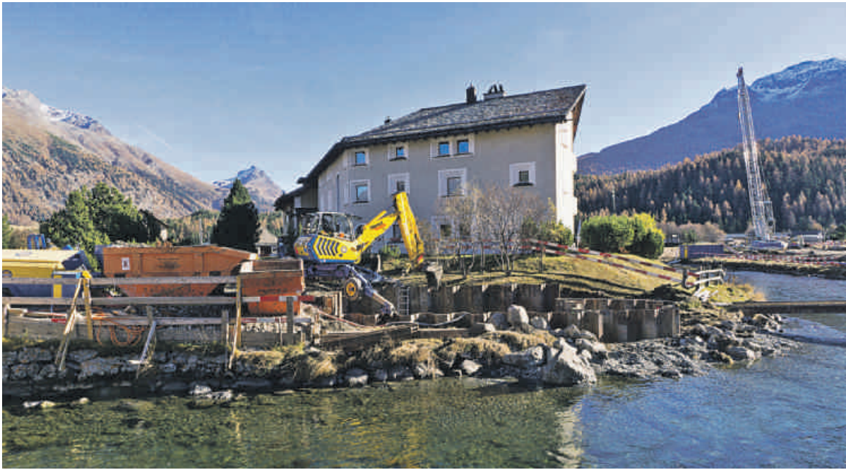
Ein Bild von den Bauarbeiten im November des letzten Jahres. Mittlerweile sind diese praktisch abgeschlossen, was bleibt, ist eine massive Kostenüberschreitung. Foto: Reto Stifel
