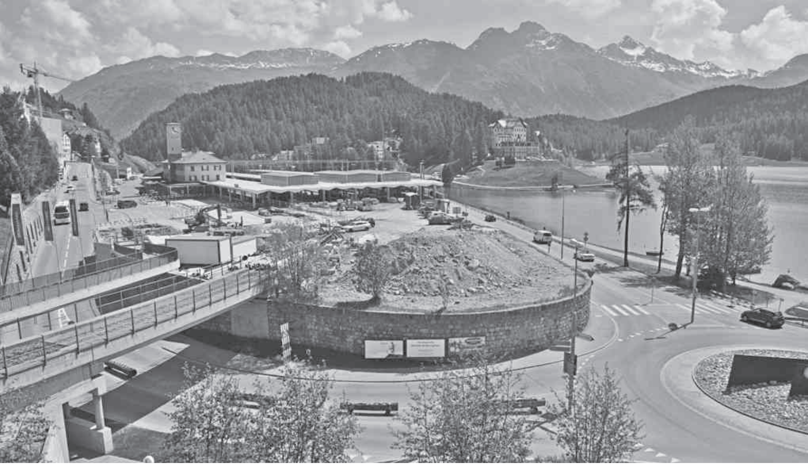
Auf dem St. Moritzer Bahnhofsareal wird derzeit intensiv gearbeitet. Bis zur Einweihung des neuen Bahnhofs am 25./26. August soll sich das Gelände von seiner besten Seite zeigen. Ohne Edy-Skulptur. Foto: Marie-Claire Jur
