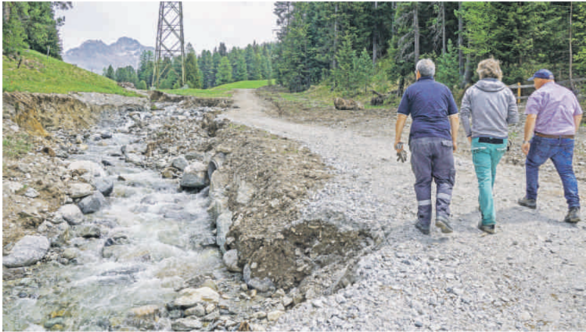
Augenschein am Bachbett des Ovel da Staz in St. Moritz-Bad. Die Einsatzleitung der Feuerwehr hatte Montagnacht Befürchtungen, dass das Hochwasser das Fundament des Starkstrommasten unterspülen könnte. Foto: Jon Duschletta
