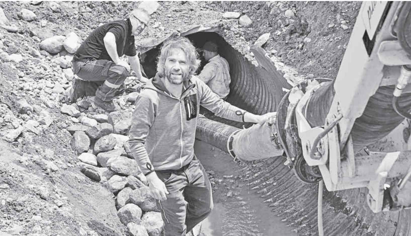
Der Wasserbau-Ingenieur Peter Mosimann (vorne) begutachtet mit dem St. Moritzer Feuerwehrkommandanten Fredi Zarucchi die aufwendigen Absaugarbeiten am unterirdischen Kanal des Ovel da Staz. Dieser quert das Wohn- und Gewerbequartier Surpunt und wurde durch das Unwetter völlig verstopft. Foto: Jon Duschletta
