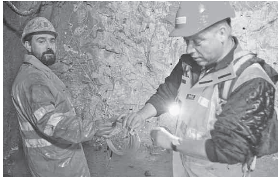
José Olivera (links) wartet auf das «Okay» zur Sprengung des nächsten Abschlags. Silvano Colturi (mittleres Bild links) und Jürgen Ebenhög prüfen gemeinsam die miteinander verbundenen Zündkabel an der Abschlagsstelle, bevor sie die Baustelle sichern und den Rückzug in die Sicherheitsnische antreten. Ohne die Schutzpatronin der Bergleute, die heilige Barbara, geht auch im Tunnelbau nichts (rechts).
