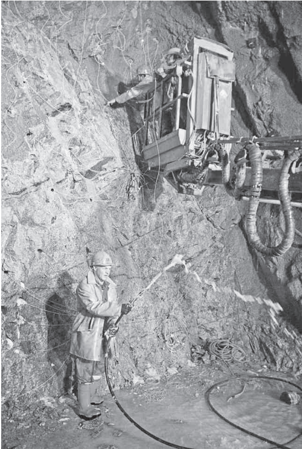
Die Mineure füllen die 110 Bohrlöcher der Abschlagswand «Süd» mit bis zu 500 Kilogramm Emulsionssprengstoff und verbinden die Sprengladungen mittels Zündkabeln zu Sprengsektoren. Im Bild rechts unten sind die beiden zwölf Zentimeter grossen Bohrlöcher zu sehen, welche zuerst gezündet werden, um der gesprengten Felsmasse Platz zu geben, sich auszudehnen. Fotos: Jon Duschetta
