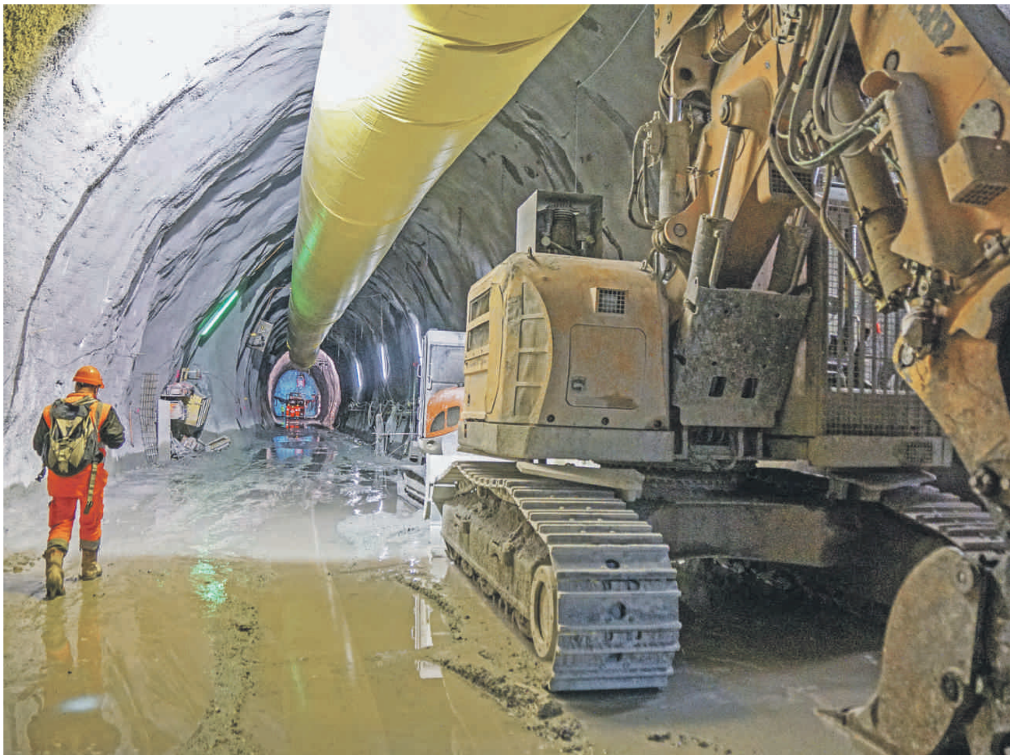
Staub, Dreck, Schlamm, Wasser, Kunstlicht und Lärm sind die Hauptbegleiter der Mineure im Stollen Süd des neuen Albulatunnels II, der bis zur Eröffnung noch Ladina-Tunnel heisst. Der Name geht übrigens auf die ehemalige Gemeindepräsidentin von Bever, Ladina Meyer, zurück, die als Tunnelpatin des Südvortriebs amtiert.
