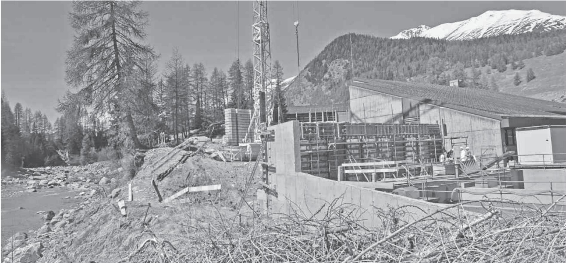
Eine Grossbaustelle am Inn bei S-chanf. Die Stützmauer aus Beton wird derzeit erstellt.
