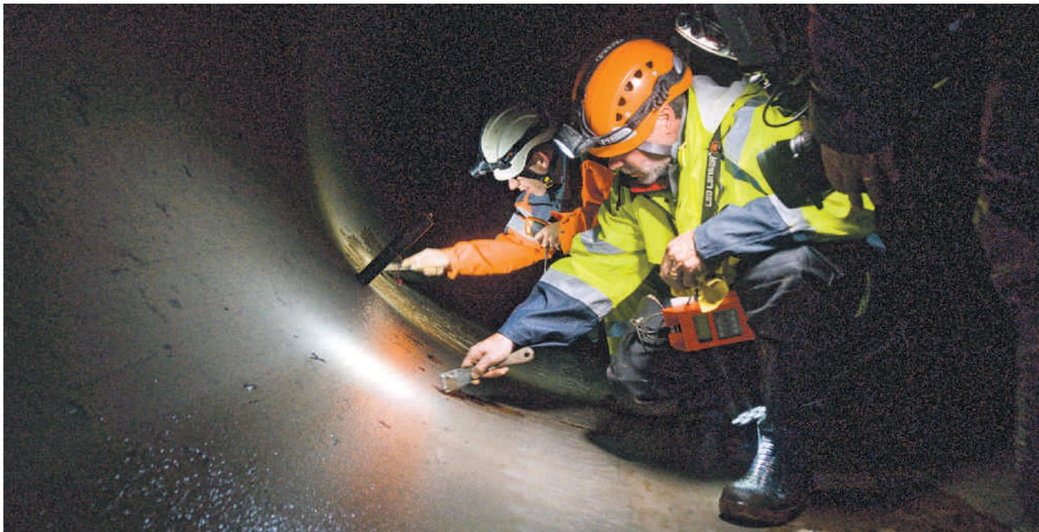
Der Leiter Instandhaltung Disposition und Verantwortlicher Stauanlagen, Gian Franco Kirchen (vorne) und Kaspar Fuchs, Mitarbeiter Bau und Unterhalt der Axpo, inspizieren den 318 Meter langen Druckstollen zwischen dem Maschinenhaus Ova Spin und dem Steigschacht zum Wasserschloss. Foto: Jon Duschletta
