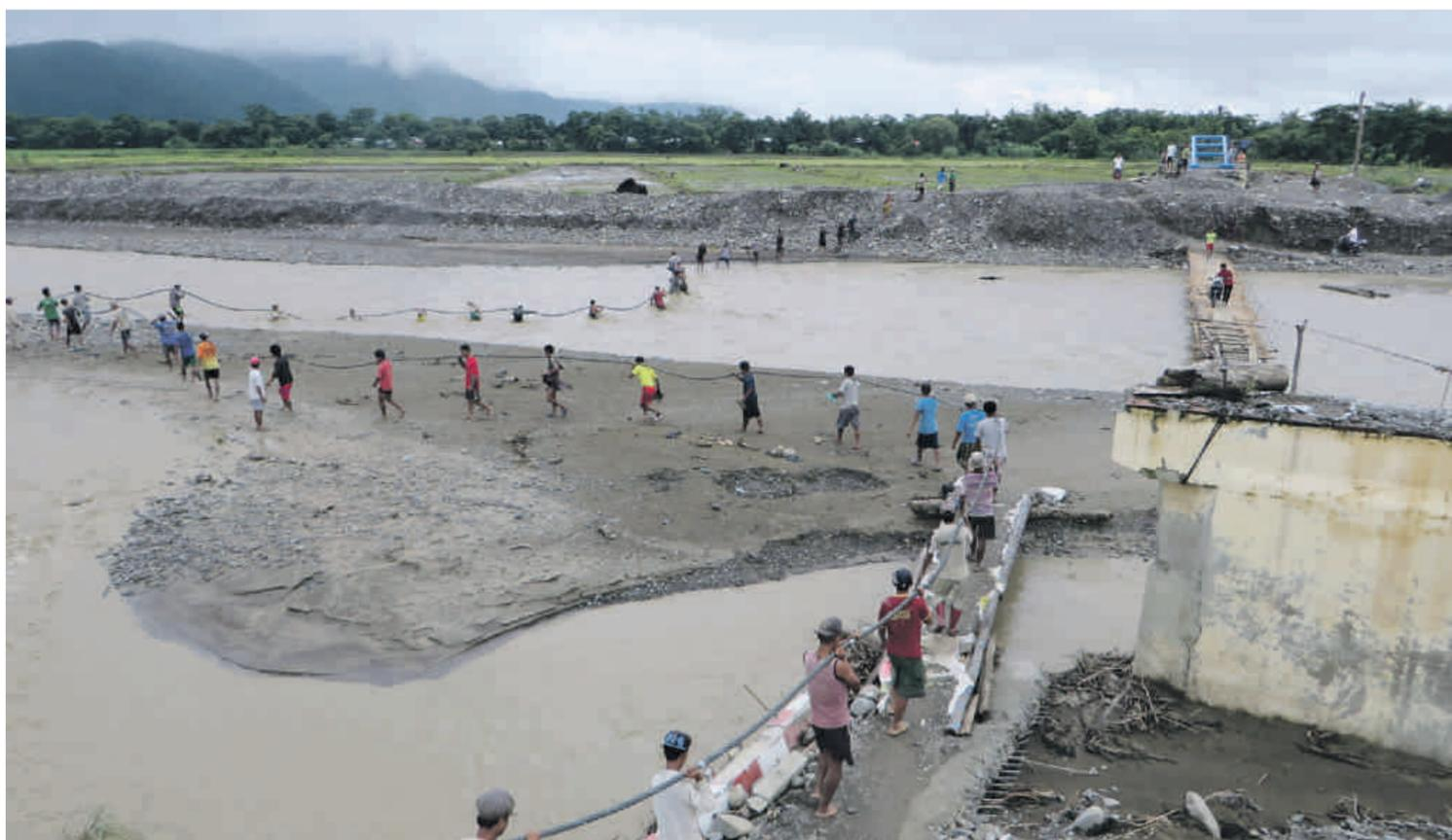
Das Seil der Brücke in Hla, Sagaing, Myanmar muss über den Fluss gebracht werden.
