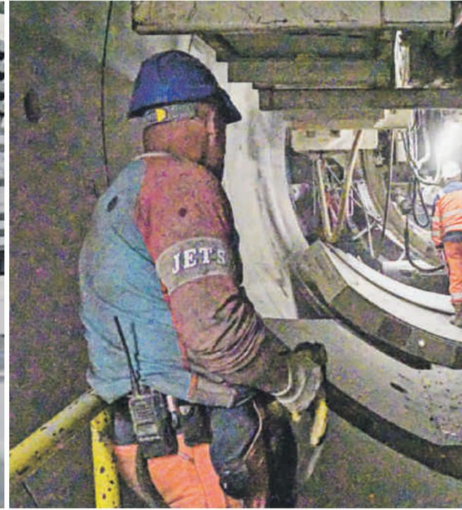
In Mariastein (A) hat der Tunnelvortrieb nach dem Unterbruch wieder begonnen. Die Stollenbahn bringt Ausbruchmaterial ans Tageslicht und fährt anschliessend wieder Hinterfüllkies und die Tübbing-Fertigbetonelemente zur Verkleidung des Druckstollens in den Berg.
