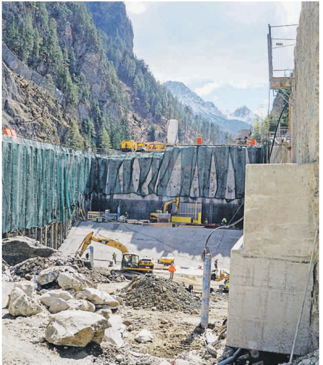
Unterhalb von Martina entsteht zur Zeit das Stauwehr Ovella. Die Steinschutzarbeiten im steilen Gelände und die Baugrubensicherung haben länger gedauert als geplant und verursachen Mehrkosten.
