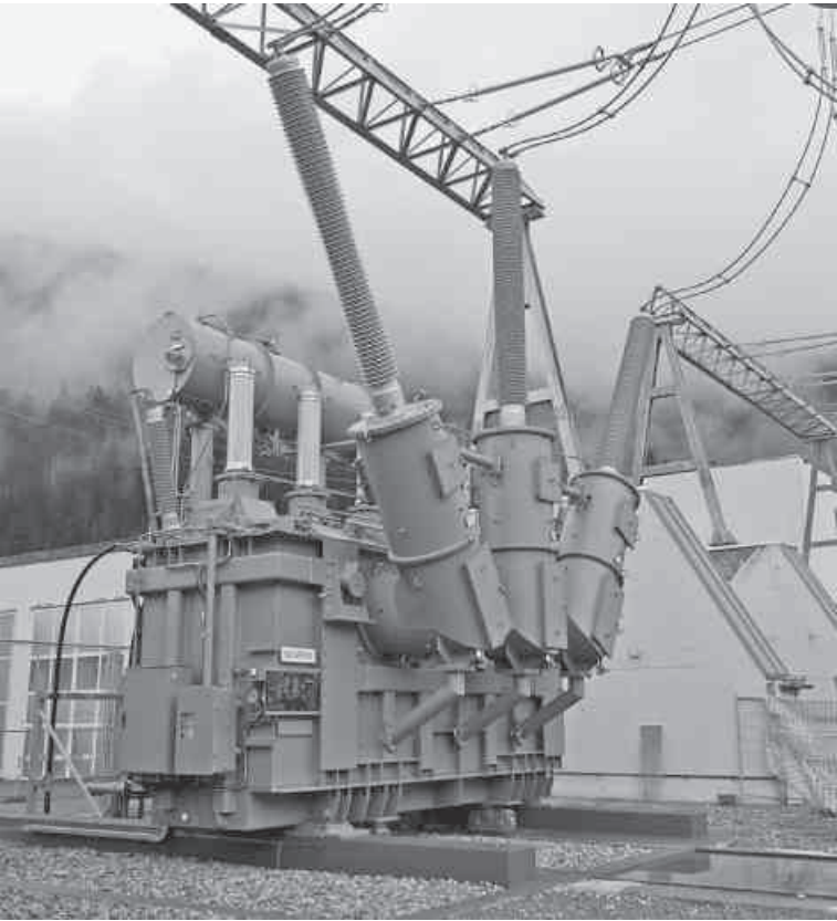
Il seguond transfuormatur es montà ed in funcziun.
