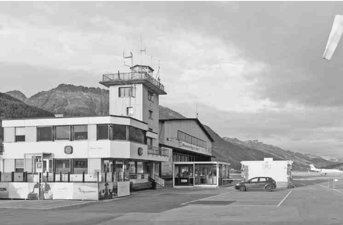
Am Regionalflughafen in Samedan sollen in den kommenden fünf Jahren rund 120 Millionen Franken investiert werden.
