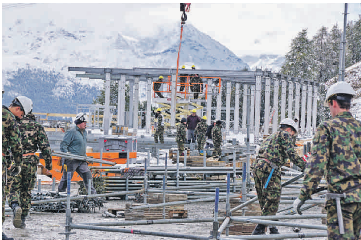
Die Schweizer Armee (im Bild während den Tribünenaufbauten im Oktober) stellt der Ski-WM rund 5000 Dienstage weniger als geplant zur Verfügung. Das wiederum verursacht Mehrkosten beim Zivilschutz. Foto: Jon Duschletta
