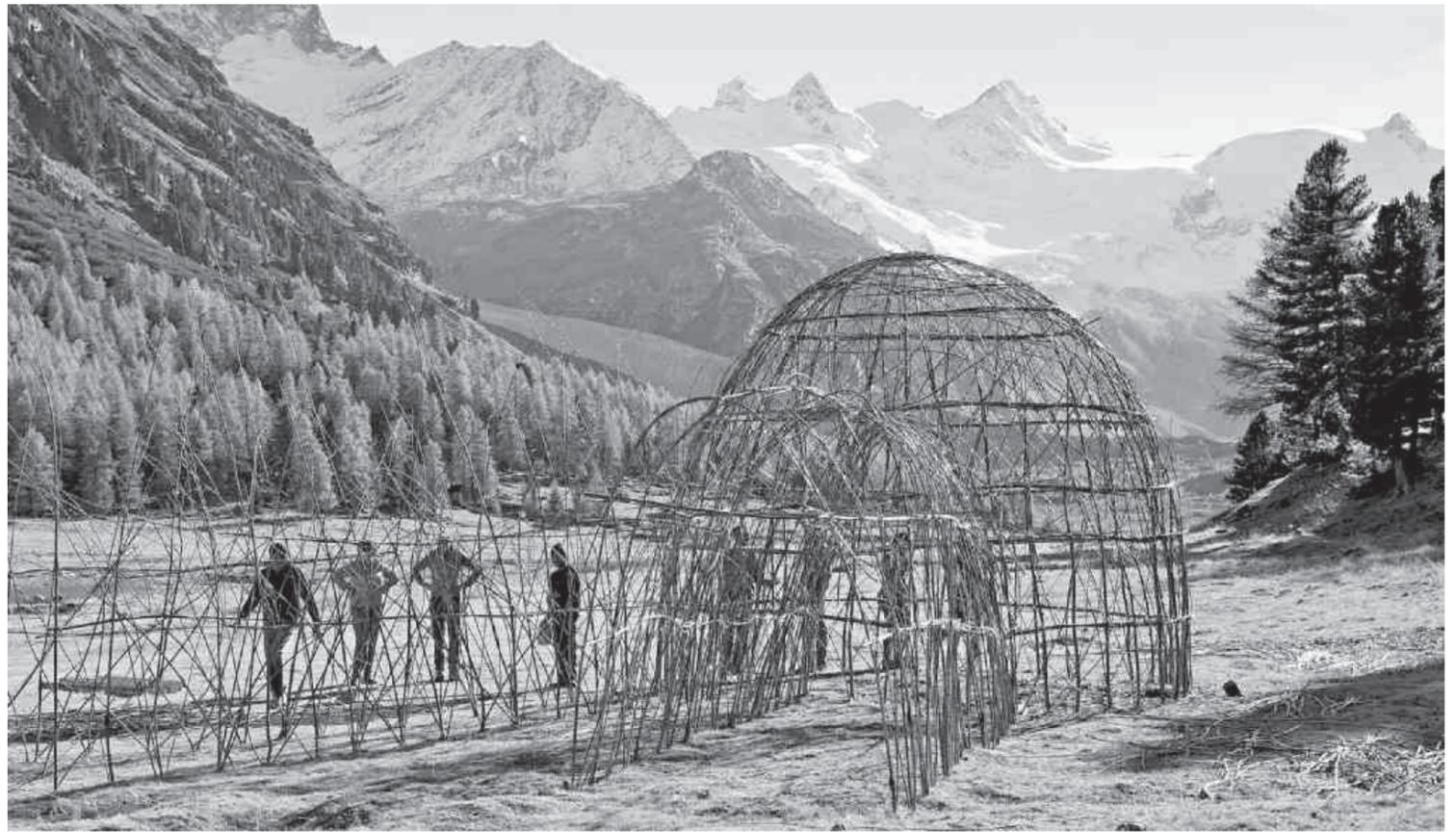
**Weiden bilden das einfache und bewährte Grundgerüst der Ice-Stupa welche derzeit beim Morteratschgletscher entsteht. Je nach Temperatur kann vielleicht schon diese Woche mit der Eisbildung begonnen werden.**
