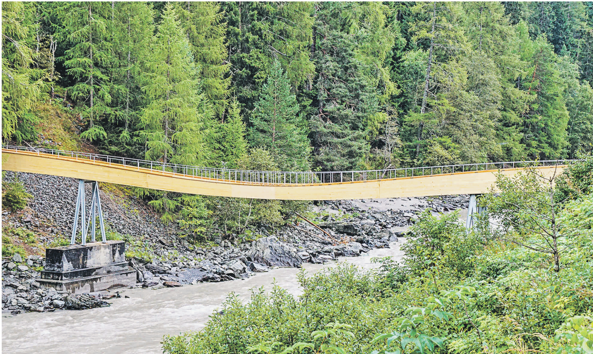
Restà es be il lō da la traversada da l'En «Güstizia» ed ils duos vegls pilasters da beton a las rivas dal flüm. La nouva punt da la Güstizia tanter Zernez e Susch es gnüda construida d'intrapraisas indigenas in fuorma ligera, fluida e sorprendenta.
