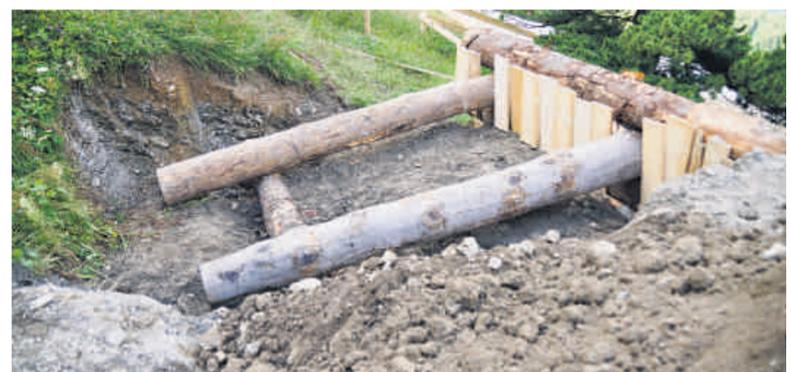
Engadiner Fichten-Rundholz wird auf Salastrains aktuell in temporäre Gelände-Terrassierungen eingebaut und später wiederverwendet.
