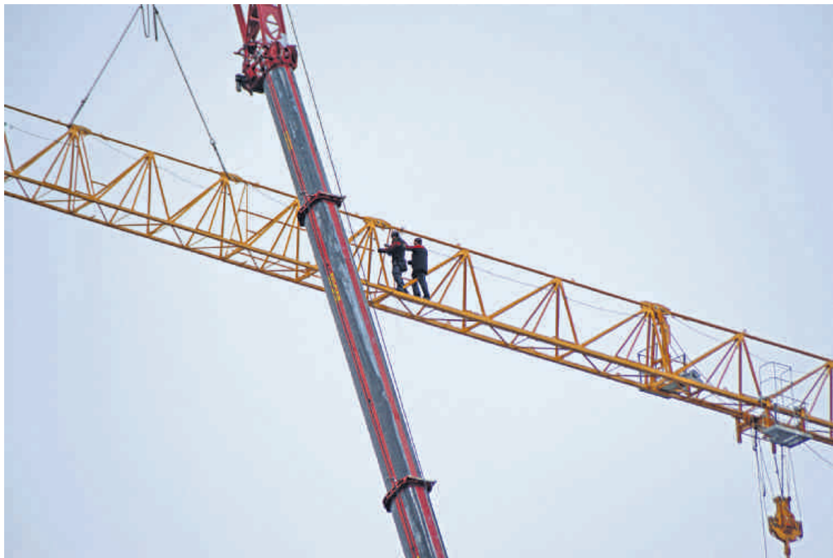
Kürzlich erfolgte auf der Baustelle Areal Tinus in St. Moritz-Dorf die Montage des mutmasslich grössten, je im Engadin aufgestellten Baukrans. Für die Wintersaison muss dieser allerdings wieder weg. Foto: Jon Duschletta
