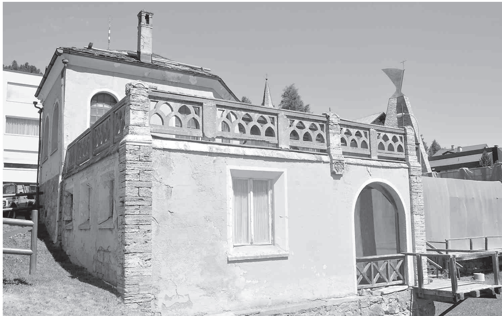
Für die Ski-WM wurde der über 110 Jahre alte Kulm-Pavillon aus dem Dornröschenschlaf erweckt.
