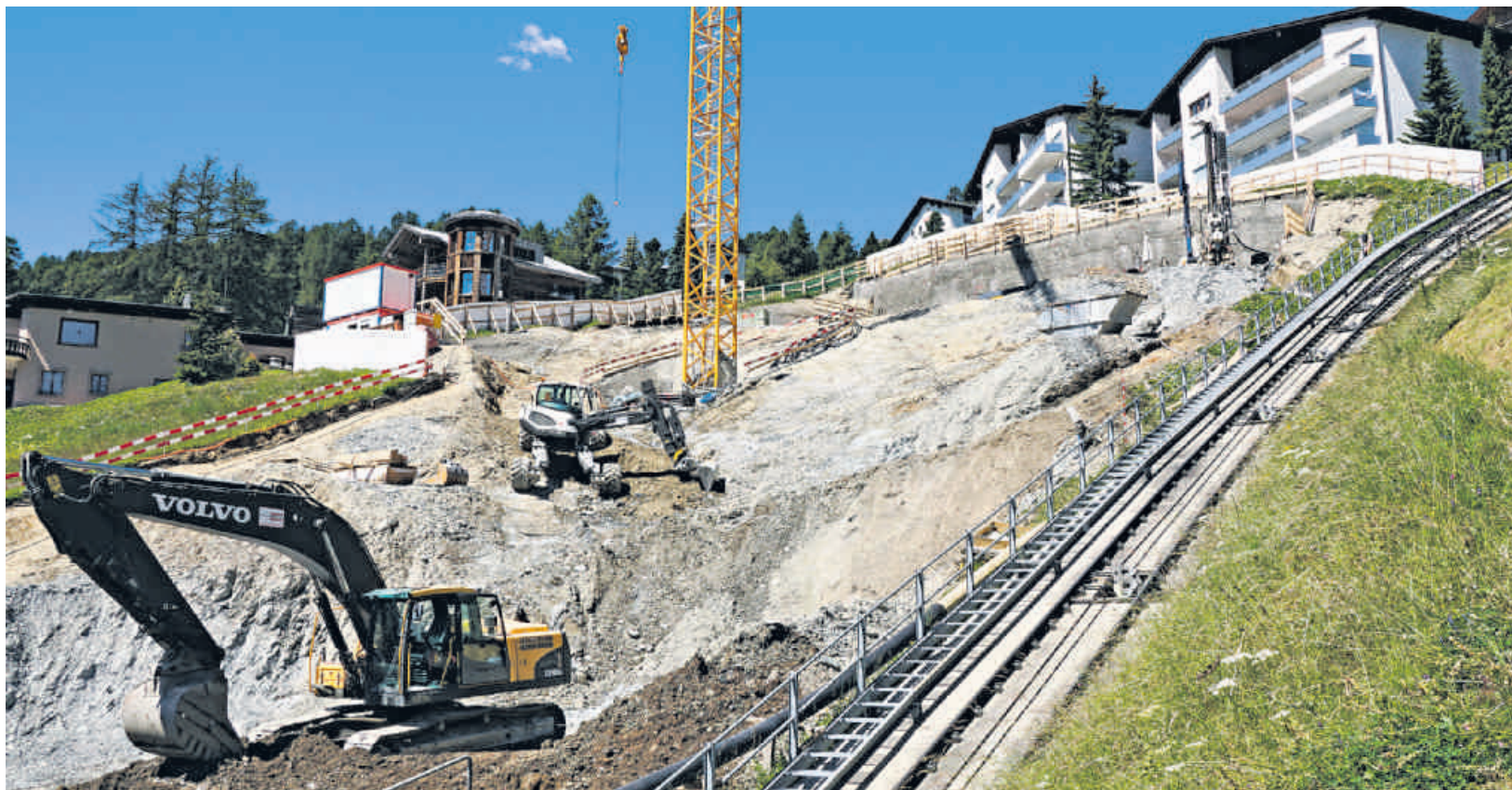
Lange Zeit lief nichts auf dem Areal Tinus in St. Moritz-Dorf. Jetzt sind die Baumaschinen für die nächsten zweieinhalb Jahre aufgeföhren. Ganz rechts sind die Gleise der Chantarella-Standseilbahn zu sehen.
