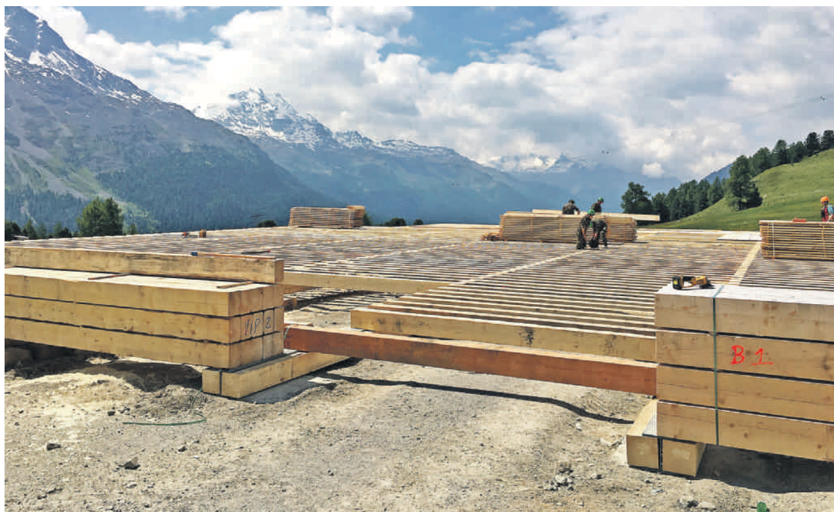
Auf Salastrains haben die Arbeiten für die Infrastruktur begonnen. Im Bild der Untergrund für das zweistöckige Hospitality-/VIP-Zelt. Foto: Ski WM St. Moritz 2017
