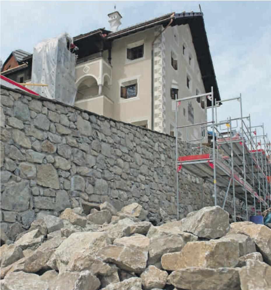
Der Blick von aussen und jener von innen: Die Bruchsteinmauer vor dem Engadiner Museum wurde dem Original von 1906 nachgebaut und tritt markant in Erscheinung. In einer knapp 500 Jahre alten Stube ist ein Spezialist mit der Sanierung und Reinigung des Täfers beschäftigt.
