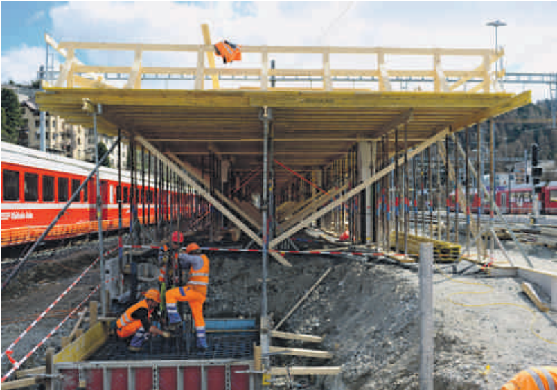
Die gelben Kästen bilden die Basis für die Dachstützen und verschwinden nach der Bauzeit wieder. Die Passagiere werden beim Aus- und Umsteigen vom Kopfperron aus die beeindruckende Panoramaansicht von St. Moritz haben (Bild links). Auch zwischen den Gleisen 1 und 2 entstehen Stützen, ein Dach und darunter ein neues Perron (Bild rechts).
