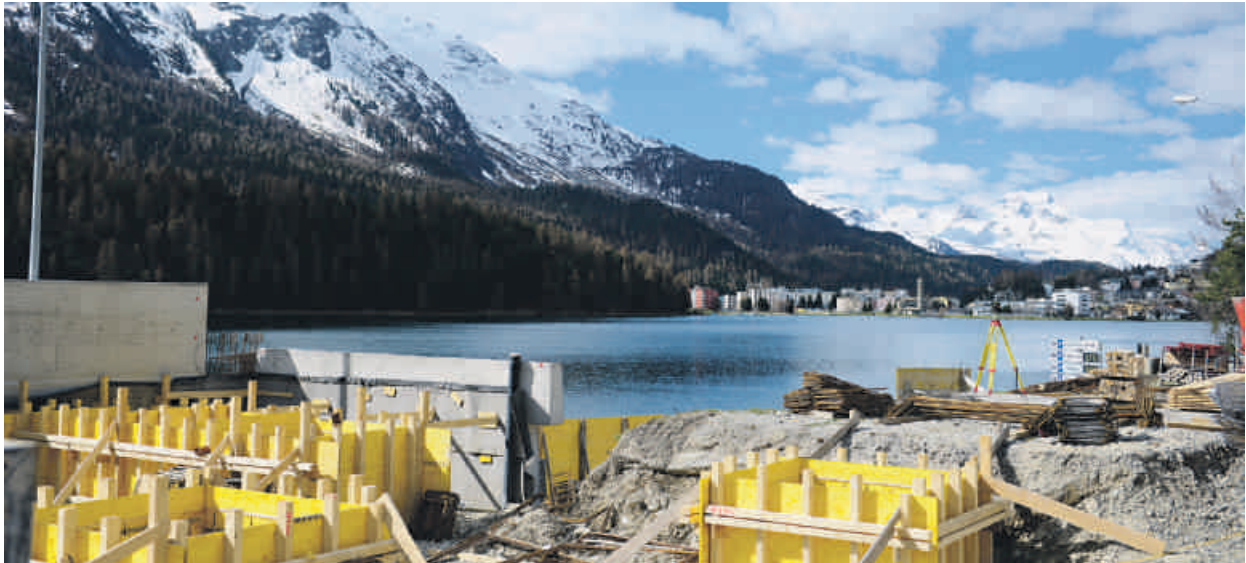
Die gelben Kästen bilden die Basis für die Dachstützen und verschwinden nach der Bauzeit wieder. Die Passagiere werden beim Aus- und Umsteigen vom Kopfperron aus die beeindruckende Panoramaansicht von St. Moritz haben (Bild links). Auch zwischen den Gleisen 1 und 2 entstehen Stützen, ein Dach und darunter ein neues Perron (Bild rechts).
