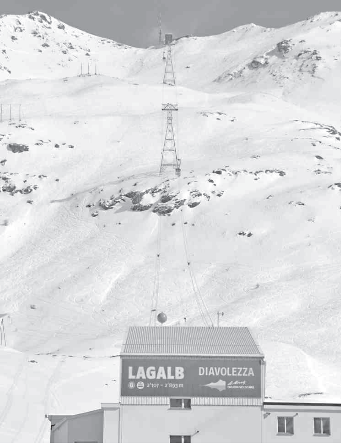
Die Lagalbbahn kurz vor Ende der Wintersaison 2015/16. Bekommt sie noch eine Chance? In sechs Wochen soll diese Frage geklärt sein.
