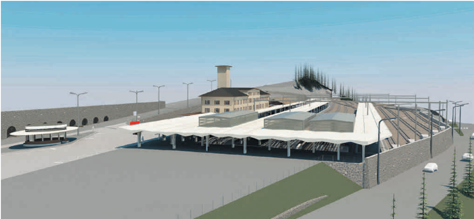
Die Businsel ganz links wird erst 2017 entstehen. Gut sichtbar ist die grosszügige Kopfperronüberdachung, die es den Passagieren ermöglicht, ohne die Unterführung zu nutzen, von und zu allen Gleisen zu laufen. Die Visualisierung zeigt den Bahnhof nach dem Umbau.
