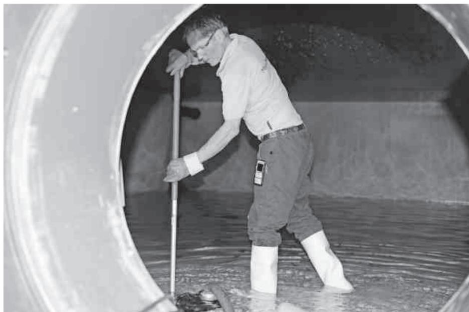
Wenn ein Badebecken geleert wird, landet das Wasser im Schwallwasserbecken im Keller. (Bild links) Auch dieses wird während der Revision abgelassen und dann von innen von einem Mitarbeiter gereinigt, ausgespült, getrocknet und desinfiziert. Eine Schutzausrüstung mit Brille, Handschuhen und Gummistiefeln ist dabei für das Team ein Muss. (Bild rechts)
