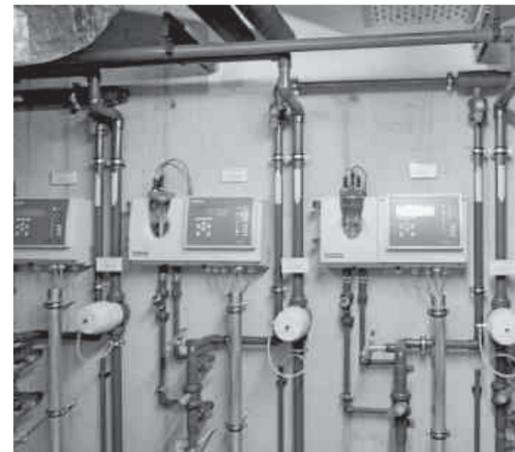
Viel Technik im Ovaverva, z. B. für die Stromversorgung. Die Anlage rechts misst permanent den Wasserchlorgehalt.
