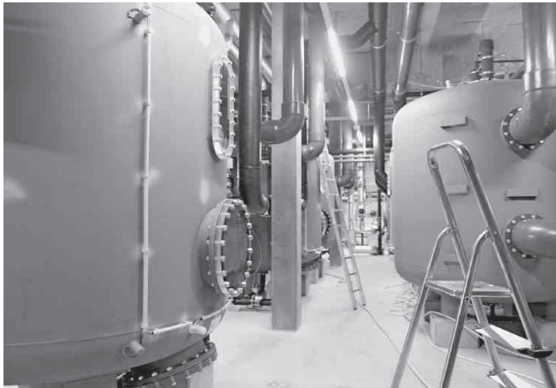
Der Keller im Ovaverva ist mit diversen Filter-, Reaktions- und Auffangbecken ausgerüstet, die Wasser für unterschiedliche Temperaturbereiche aufbereiten. Insgesamt drei Wasserkreisläufe sind nötig, da es 28 Grad im Schwimmer- und im Springerbecken, 30 Grad im Lernschwimmbecken und 34 Grad im Aussen- und im Spabad hat.
