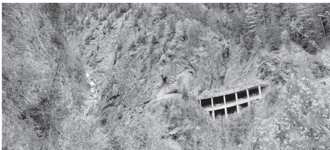
Das «Val Alpetta»-Nordportal (oben) beweist die topographische Sonderstellung der Samnaunerstrasse. Oben rechts das bestehende Südportal des 90 Meter langen «Val Pischöt»-Tunnels und unten der Anstich zum neuen, 325 Meter langen «Val Pischöt»-Tunnel, welches in einem grossen Bogen die Val Pischöt quert. Dieser 16-Millionen-Franken-Tunnel gilt als eigentliches Herzstück des Ausbaus.
