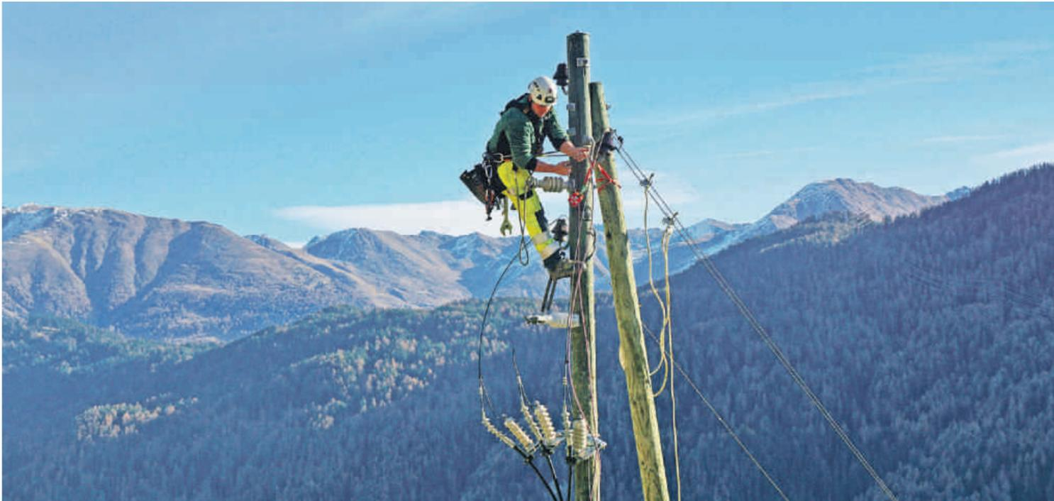
Repower-Netzelektriker Emanuele Rada (Bild) hat zusammen mit seinem Arbeitskollegen Corsin Fasciati am Donnerstag unterhalb von Tschlin einen Mittelspannungsmasten der Freileitung vogelsicher umgerüstet. Vor allem Greifvögel und Eulen profitieren von solchen Massnahmen. Foto: Jon Duschletta
