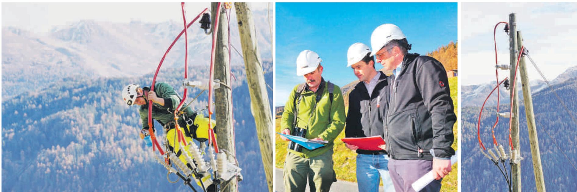
Emanuele Rada (oben) ist Netzelektriker-Gruppenleiter bei Repower. Er rüstet in luftiger Höhe einen gefährlichen Endmasten der Mittelspannungs-Stichleitung unterhalb von Tschlin vogelsicher um (Bild rechts). Mittleres Bild v.l.n.r.: David Jenny, Schweizerische Vogelwarte Sempach, Giacom Krüger, Repower und Jachen Gaudenz, Engadiner Kraftwerke EKW. Foto: Jon Duschletta
