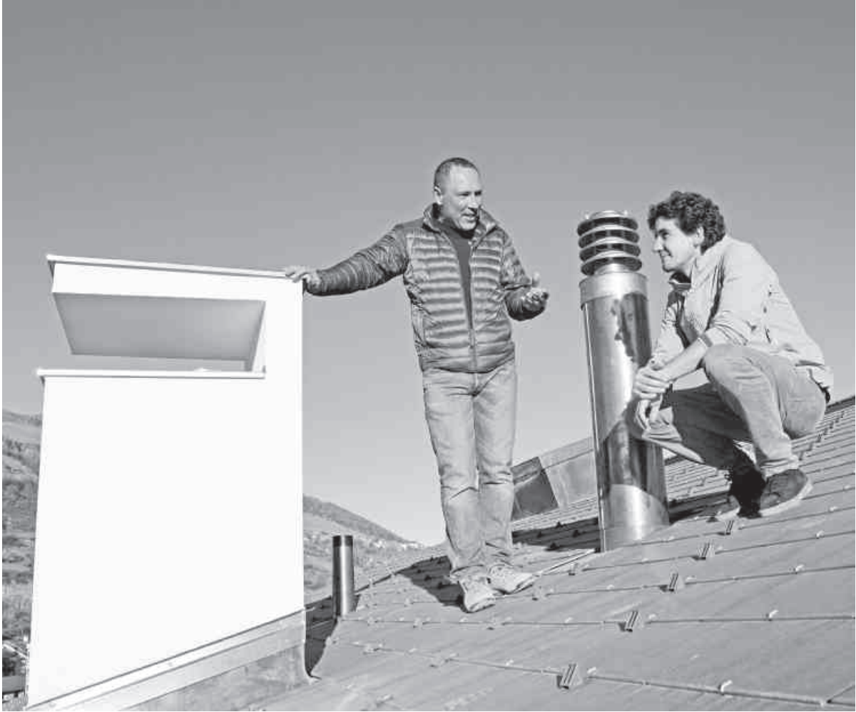
Die beiden Haustechnik-Spezialisten Dario Cao aus Brusio (links) und Carlo Vassella aus Poschiavo besprechen sich auf einem der Dächer der Minergie-A-Überbauung «Monolit» in Scuol. Foto: Jon Duschletta
