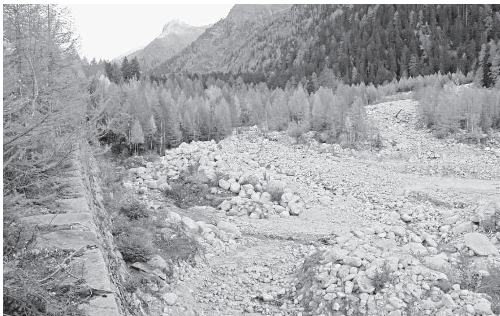
Am Standort «Crotto Albigna» haben die Gewässer im Verlauf der Zeit viel Geschiebe abgelagert.
