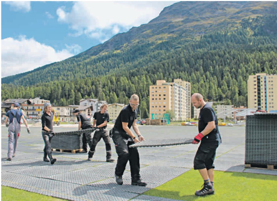
Mitarbeiter aus Freiburg im Breisgau verlegen die aus alten Autoreifen gestanzten Gummipplatten auf den St. Moritzer Polowiesenrasen. Im Hintergrund wird bereits der Quarzsand für die CSI-Unterlage verteilt. Foto: Stephan Kiener
